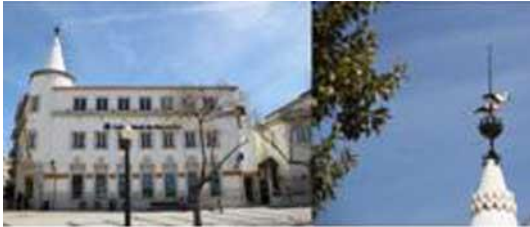
Figure 19. Caixa Geral dos Depósitos Building (site 13) (João Fonseca, Março 2012)
