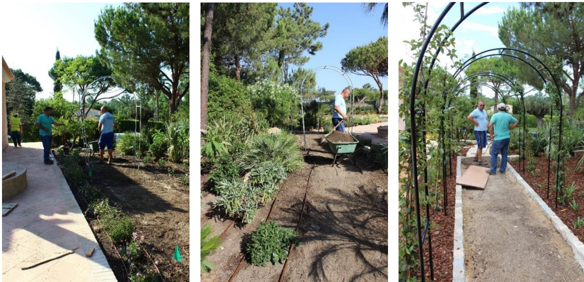
Figura 5.61: Fotografias do processo de construção dos arcos em metal ao longo do percurso
