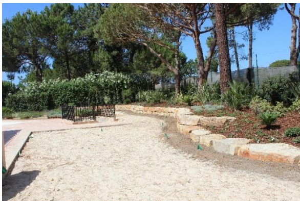
Figura 5.66: Instalação do sistema de rega por aspersão na zona de relvado
