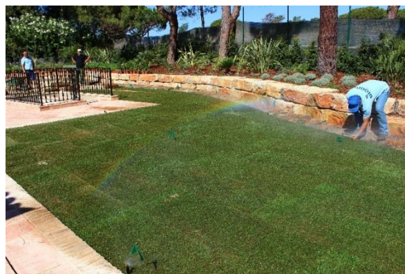
Figura 5.68: Relvado finalizado com sistema de rega a funcionar
