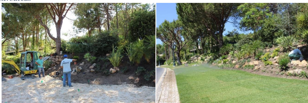
Figura 5.64: Construção do jardim da entrada da moradia Pinheiros 1-13 – revestimento e plantação do talude
