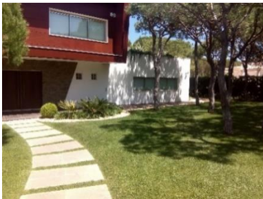
Figura 3.9: Exemplo de acesso informal em lajetas de betão retangulares
