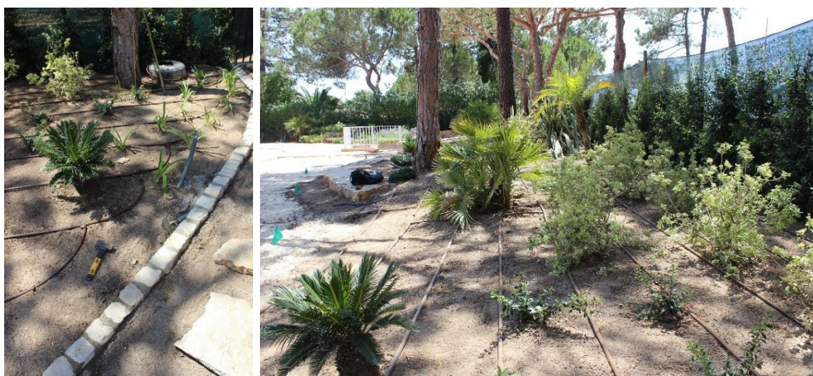
Figura 5.62-63: Instalação do sistema de rega gota-a-gota em zona de plantação de arbustos e herbáceas
