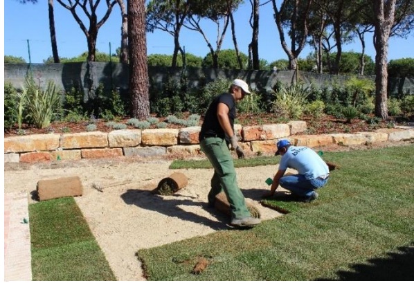
Figura 5.34: Obra quase finalizada, a efetuar-se a instalação do relvado em tapete
