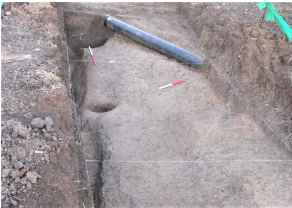
Figura B6: Plano final da sondagem 2, antes do alargamento 3 (Baptista et al., 2015).
