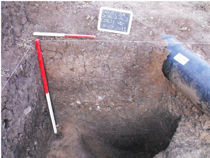
Figura B4: Corte Sudoeste da sondagem 2, antes do alargamento 3. Pode-se observar a vala para implantação do tubo de água (UEs 207, 208 e 209), e os depósitos UEs 200 e 203, e o enchimento (UE 206) da UE 210 (Baptista et al., 2015).
