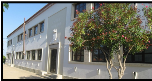
Figura 4.2 - Edifício principal da escola B em Loulé.
