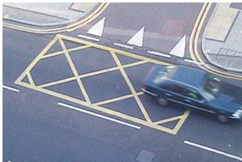
fig. 4.59 - Fotografia de redes de impedimento de paragem. 56
