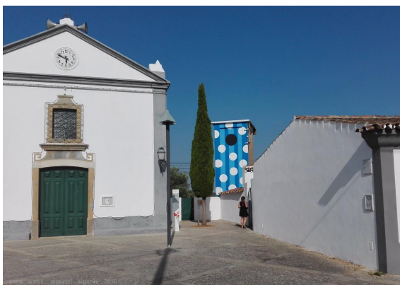
fig. 2.111 – Vista geral da intervenção.
