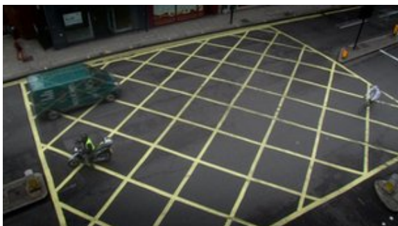
fig. 4.58 - Fotografia de redes de impedimento de paragem.
