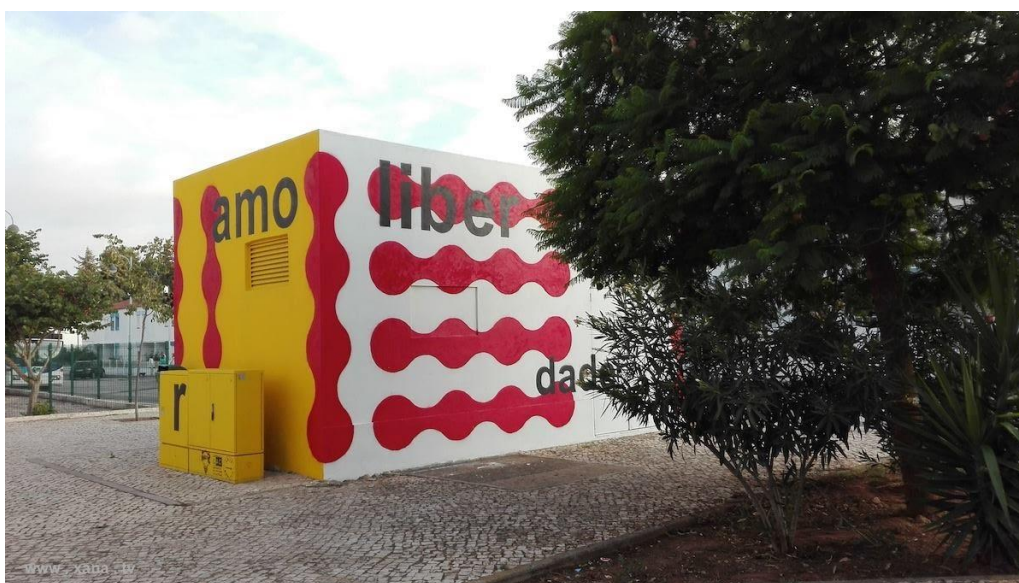
fig. 2.114 - Vista da intervenção ALS .
