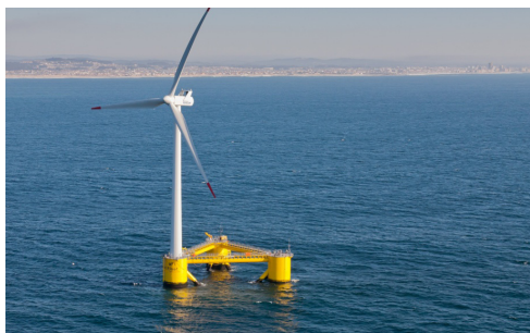
Fig. 3: Windfloat, a segunda turbina eólica flutuante do mundo operando à capacidade nominal (2 MW) ao largo da Aguçadoura, Póvoa do Varzim. (Fonte: EDP renováveis)
