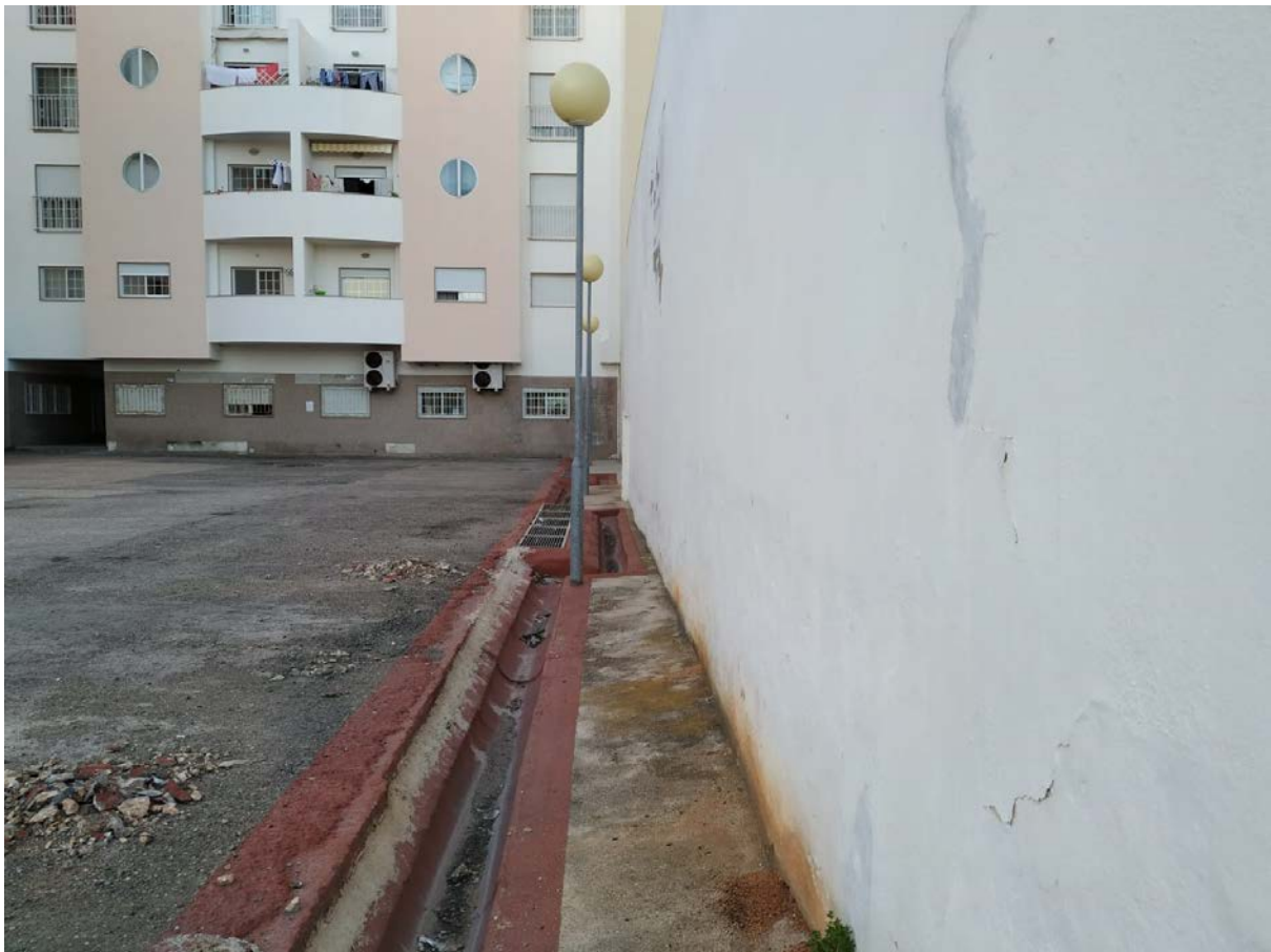
Figura 1.10 – Vista da faixa de terra que acompanha o muro na confrontação a nascente, atualmente cimentada com função de drenagem. Fonte: Autor
