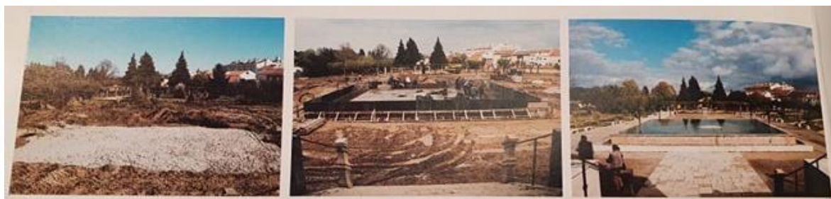
Figura 4. 3 – Parque da Cidade: da esquerda para a direita, obras do parque a 4 de janeiro de 2003; obras do parque a 26 de março de 2003; e o parque depois da intervenção da POLIS a 14 de novembro de 2003 (Fonte: O Programa POLIS em Castelo Branco – Álbum histórico).
