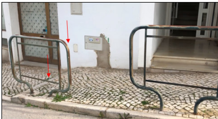
Figura 3.24 -. Degrau isolado e respetivo guarda-corpos
