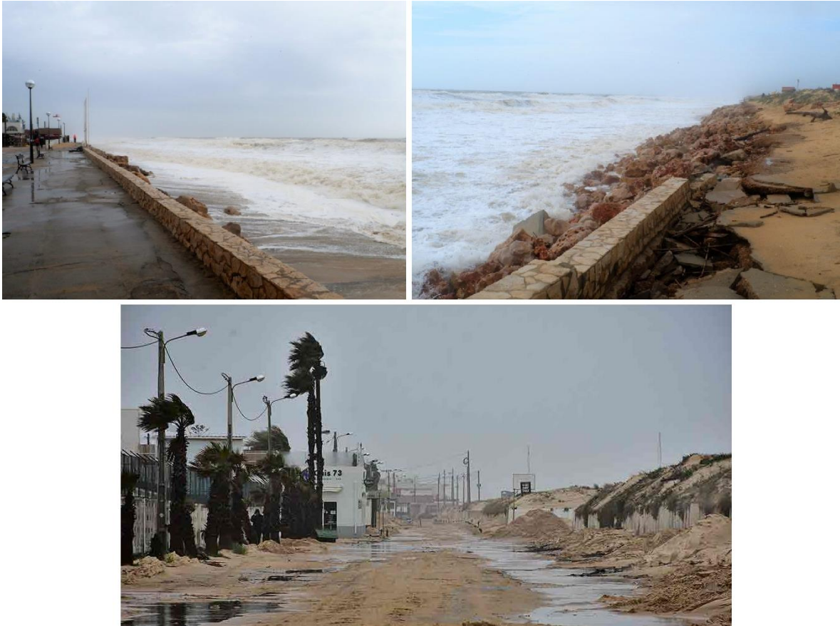
Figura 1.1 Ocorrências de erosão, galgamento e transposição de areias derivadas de tempestade (março de 2018).
