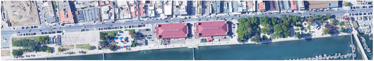
Fig.4.31 - Vista geral antes da intervenção. (Fonte: google maps).
