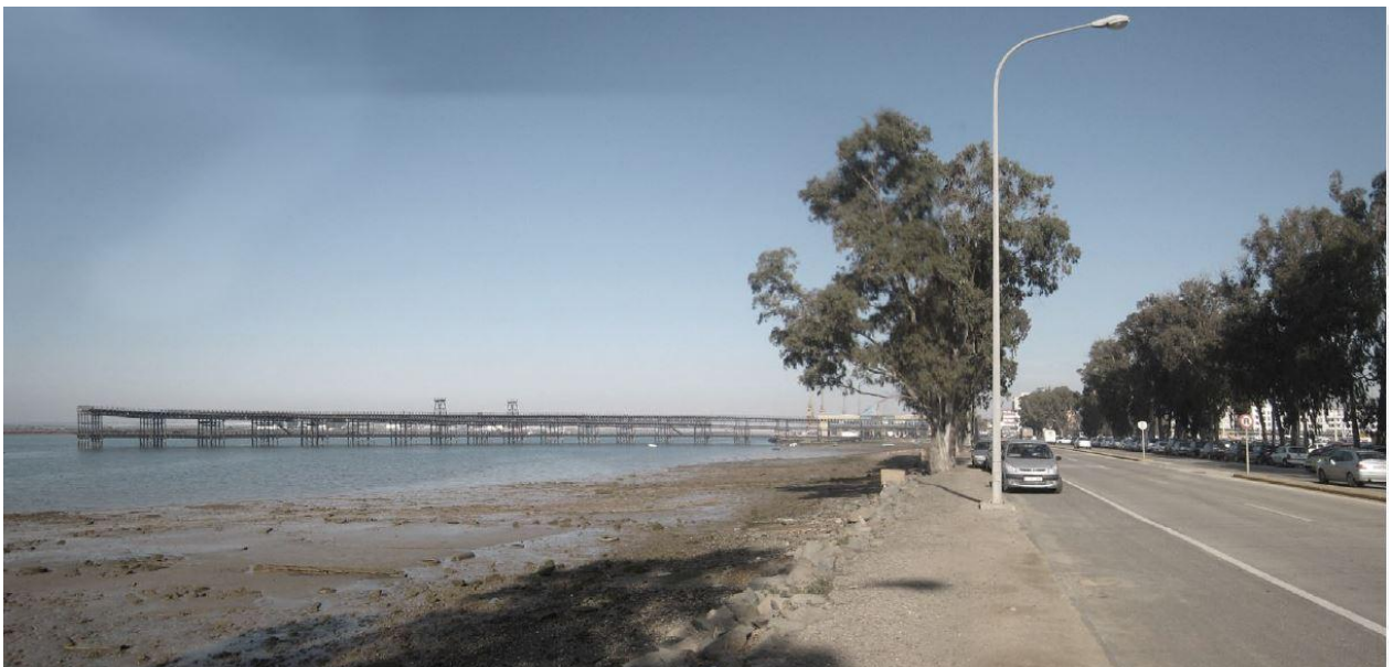
Fig.3.3 - Local antes da intervenção. Fonte: Pósteres de apresentação do projeto (Anexo I).
