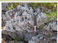
Corrosão dos lapiás – corrosão alveolar.
