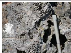
Corrosão dos lapiás – corrosão alveolar.
