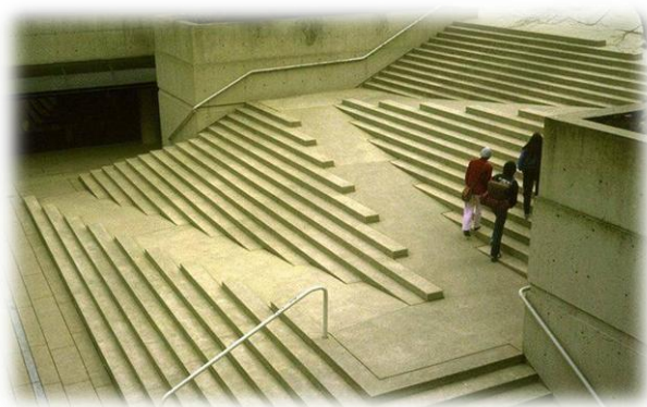
Figura 13 - Rampa integrada em escadaria
