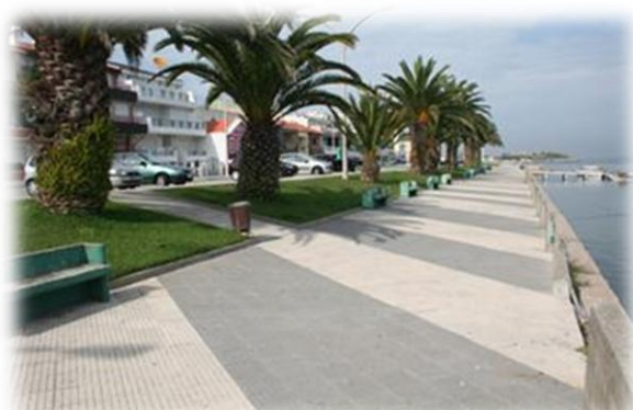
Figura 14- Circulação pedonal sem barreiras - Murtosa
