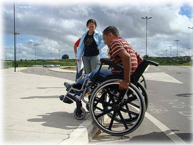
Figura 9 - Barreiras Arquitetónicas no EPU
