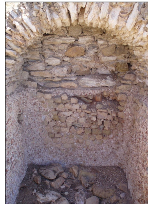
FIG. 118 Estrutura 5 (E5). Vista do interior (I.E.M.).
