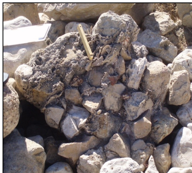
FIG. 142 Derrube 12 (D12). Muro? (I.E.M.).
