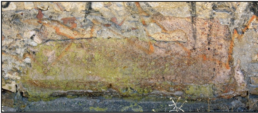
FIG. 134 Interior do barracão pombalino sul. Revestimento de opus signinum da parede do tanque que dá para o compartimento C da planta de Estácio (I.E.M.).
