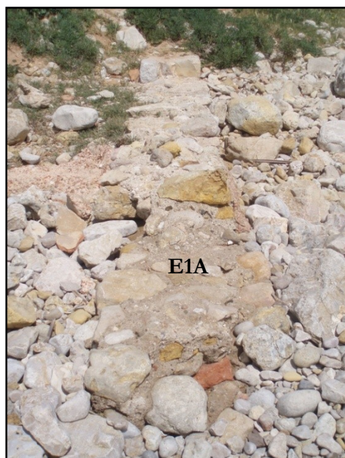
FIG 50 – Estrutura 1: muro perimetral visto de sudoeste (I.E.M.).
