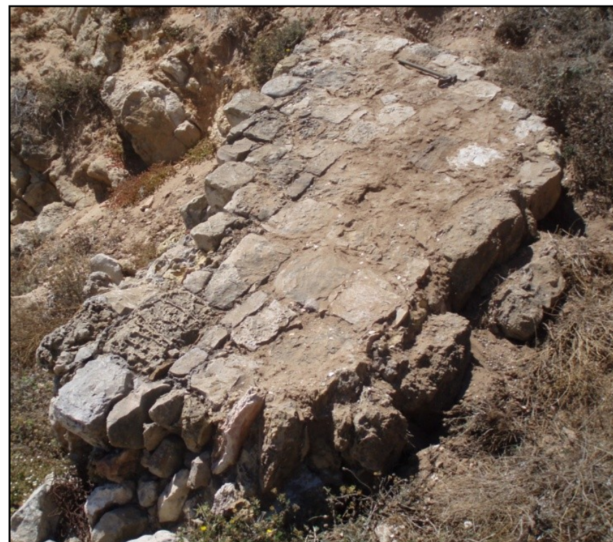
FIG. 131 Derrube 17 (D17). Fragmento derrubado do muro E6B (I.E.M.).
