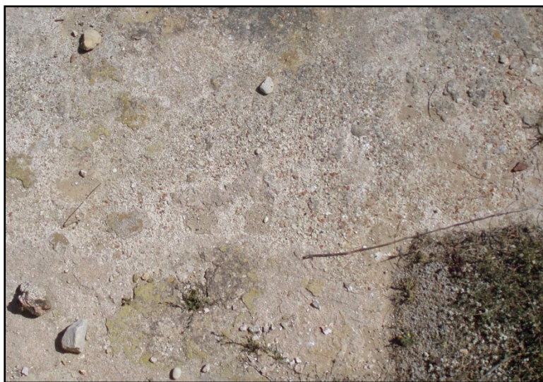
FIG. 132 Interior do barracão pombalino sul (balneário). Pavimento em opus signinum (I.E.M.).
