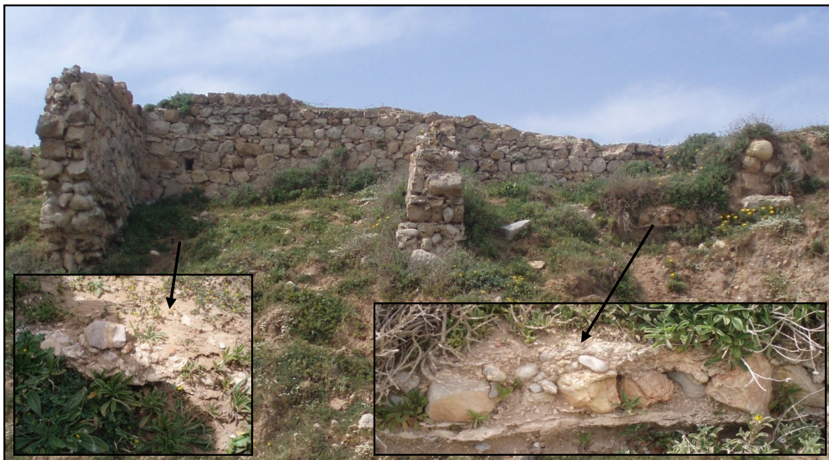
FIG. 111 Estrutura 4 (E4), vista do conjunto de sudeste, com pormenores dos pavimentos de opus signinum de ambas ad divisórias (I.E.M.).
