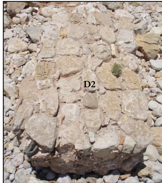
FIG 65 – Derrube 2: segmento murário (I.E.M.).
