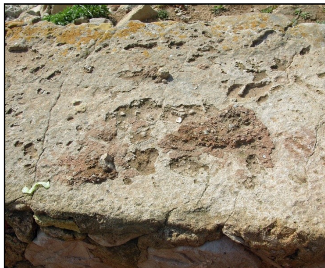
FIG 47 – Pormenor de taipa incrustada no topo argamassado do muro este da Estrutura 3 (I.E.M.).
