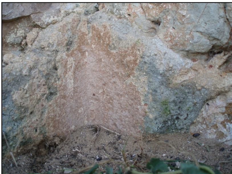
FIG. 114 Estrutura 4 (E4). Grande plano do canto inferior entre os muros E4B e E4D revestido com estuque pintado de cor acastanhada (I.E.M.).
