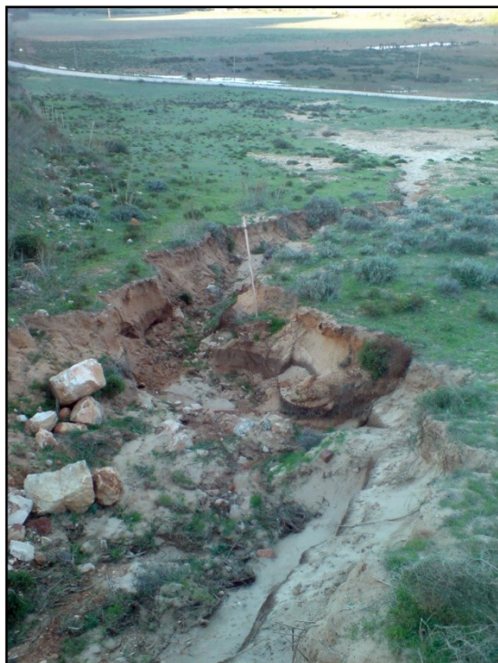
FIG. 107 Escavamento provocado pela escorrência de águas pluviais a partir do morro ponte à praia da Boca do Rio (I.E.M.).
