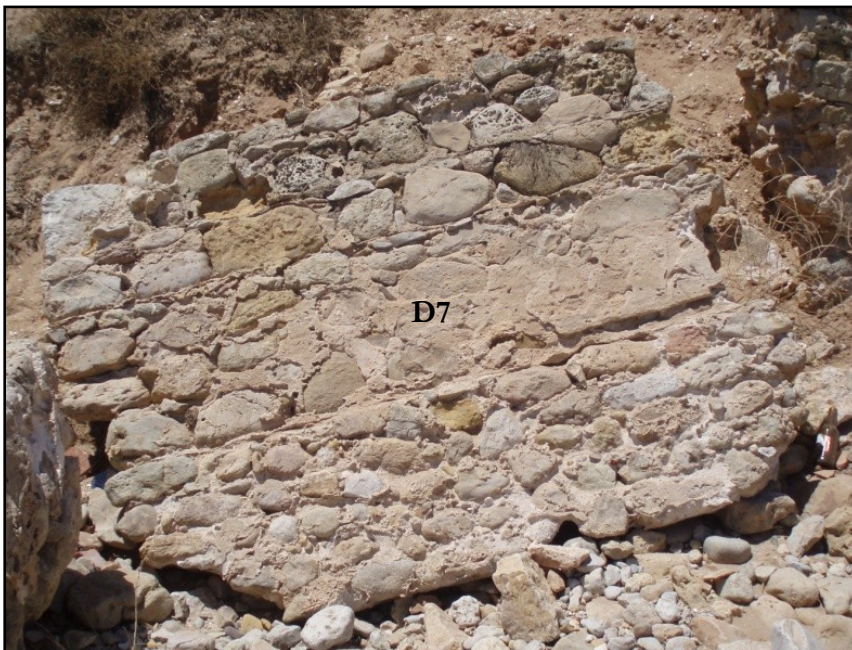
FIG 67 – Derrube 7: segmento murário (I.E.M.).
