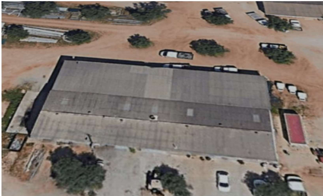
Figura 11 – Área disponível para instalação dos painéis fotovoltaicos na cobertura.
