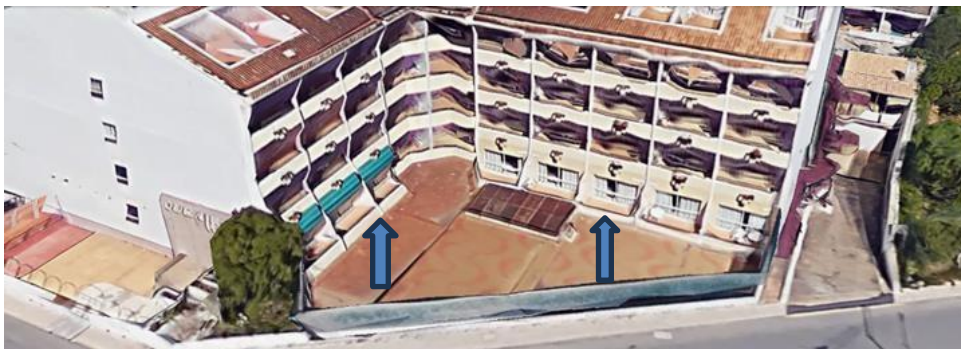
Figura 7.9 - Vista aérea para o 1º andar I
