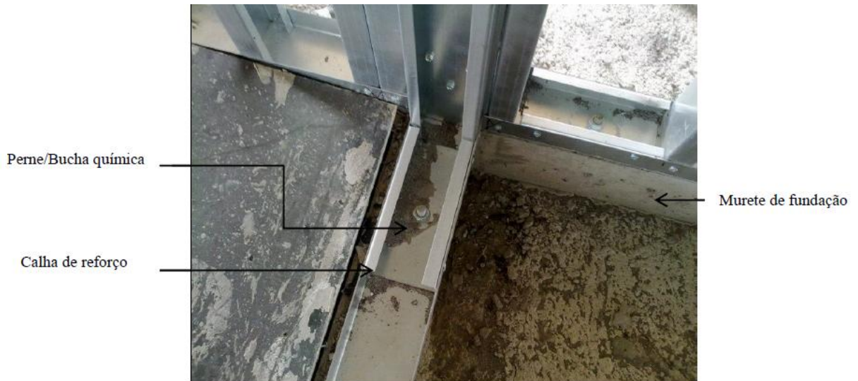
Figura 4.3 – Pormenores das ligações das ancoragens (Gouveia, D. 2015)
