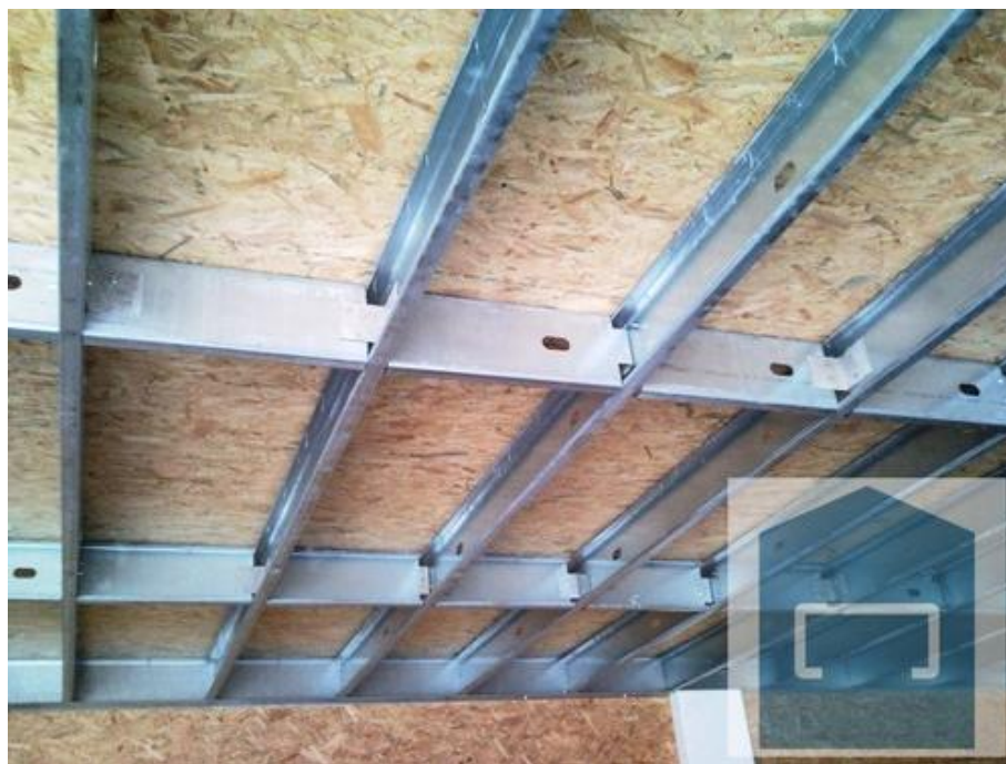
Figura 4.17- Piso estrutural com placa OSB superior já colocada (Site Futureng)
