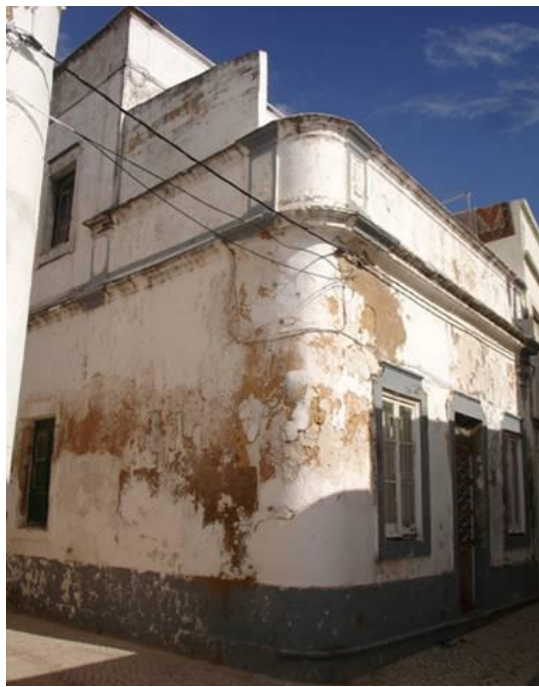
Figura 6 - Casa térrea de "risca ao meio" com mirante na rua dos Micanos (Sandra Romba 2008)
