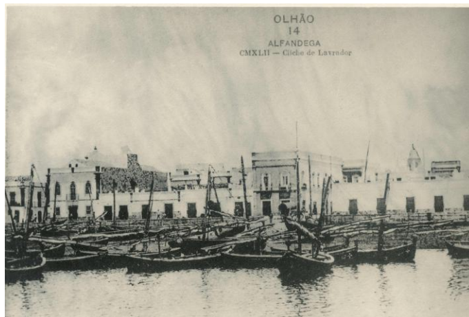
Figura 13 - Frente nascente da baixa-mar com o edifício da Alfândega no lado esquerdo e demais armazéns. (A.H.M.O.)
