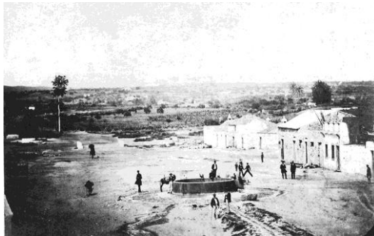
Figura 26 - Extremo norte da rua da Feira com o poço novo ao centro. É possível verificar o mau estado do eixo. Fotografia tirada ainda no séc. XIX. (A.H.M.O.)
