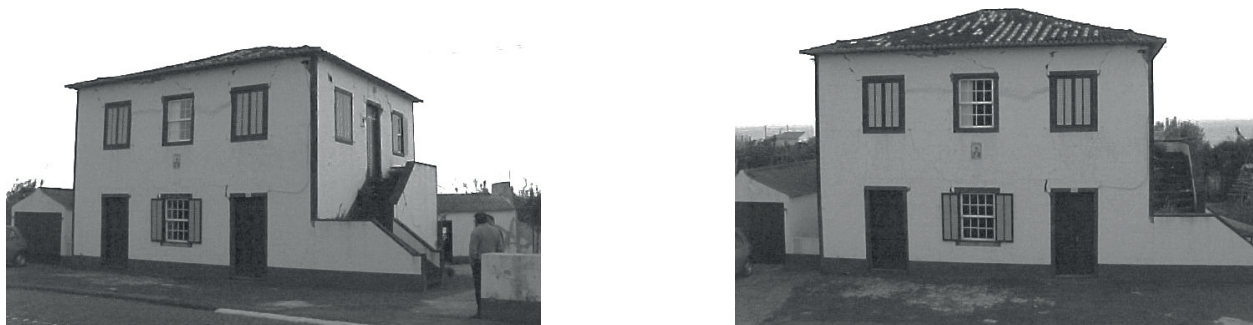
Figura 1: Vista exterior do edifício analisado, localizado na freguesia de Cedros, ilha do Faial, Açores
