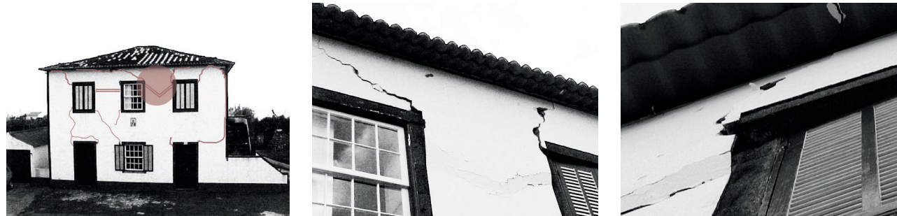
Figura 5: Distribuição dos danos efetivos observados na parede de fachada do edifício modelado, resultantes do terramoto dos Açores de 1998
