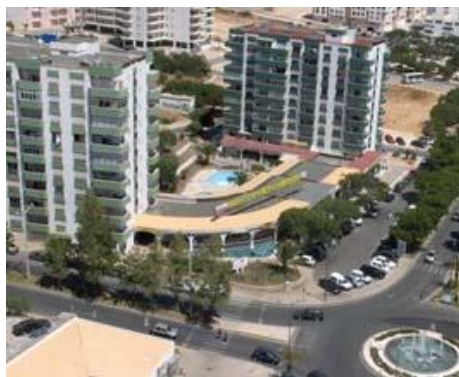
Figura 22 - Aspecto de uma avenida da área de construções modernas
