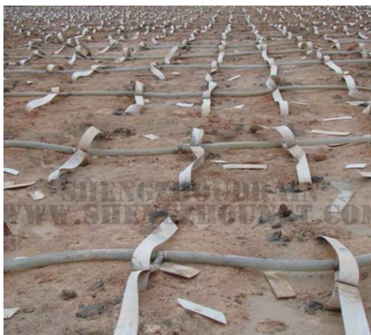
Fig.21 – Ligação de PVD a Stripdrain (retirado de http://gzshengzhou.en.made-in-china.com/product/keywordSearch?searchKeyword=harmonica , em Novembro de 2014)
