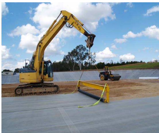
Fig.11 – Aplicação de Clay Liners na base de aterros sanitários para evitar contaminação de aquíferos (imagem retirada de http://www.amcolminerals.com.au/images/BentomatApplication.jpg , em Junho de 2015)
