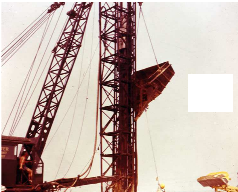
Fig.6 – Funil para posterior aplicação das areias constituintes do dreno de areia (imagem retirada de http://www.vulcanhammer.info/vibro/sand-wick-drains.php , em Abril de 2015)
