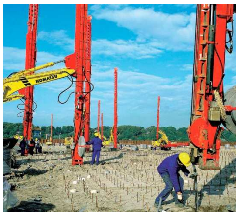
Fig.17 – Instalação de PVD (Imagem retirada de http://www.archiexpo.com/prod/menard/vertical-drains-ground-improvement-61405-151667.html , em Setembro de 2014)
