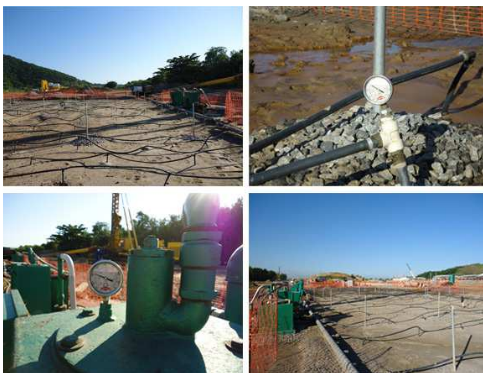
Fig.23 – Utilização simultânea de PVs, Stripdrains e bomba de vácuo (retirado de http://www.stabteco.com.br/servicos , em Abril de 2015)
