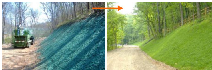
Figura 5.6. Exemplo do antes e depois da aplicação da Hidrossementeira. Fonte: Ecosalix, [s.d.]
