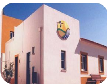
Figura 5.9. Centro de Acolhimento da Amendoeira da Serra
