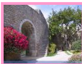
Fig.2 – escadas do castelo
