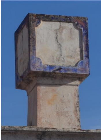
Figura 42 - Chaminé de balão em Alte. Fotografia da autora.
