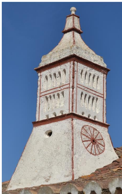
Figura 40 - Chaminé monumental com grelha de ladrilho simples em Porches. Fotografia da autora.
