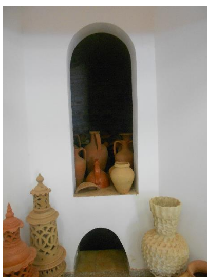
Figura 5 - Forno antigo, com caldeira para fazer o fogo e espaço para as peças cozerem. Fotografia da autora.
