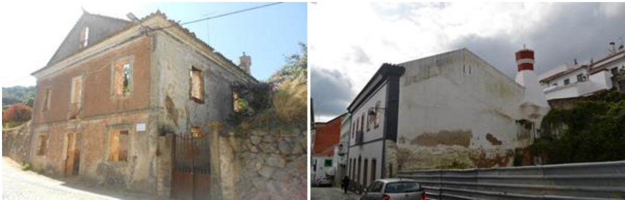
Figura 21 e 22 - Casas com andar nobre em Monchique. Fotografia da autora.
