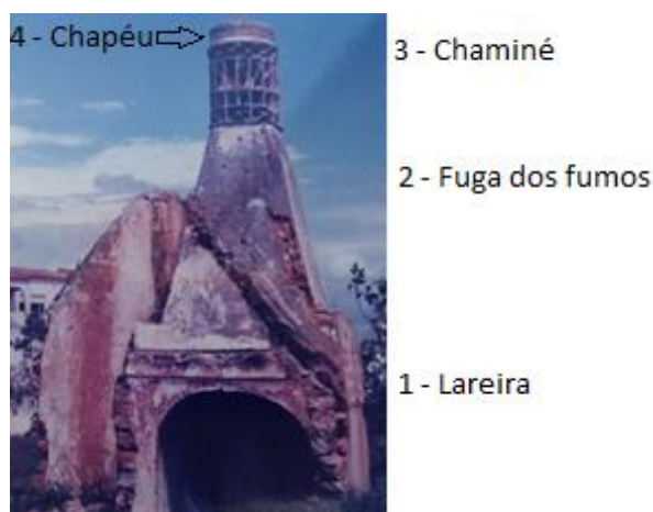
Figura 1 – Partes integrantes da chaminé. Fotografia cedida por Sr. Isidoro Correia (adaptada).
