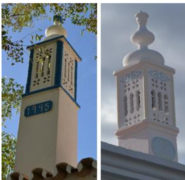
Figura 55 e 56 - Chaminé datada de 1995 localizada em Querença (esq.), juntamente com um exemplar semelhante datado de 1923 localizado em Paderne (dir.). Fotografias da autora.
