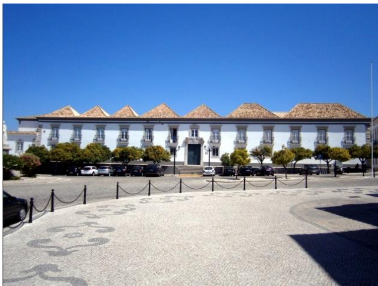
Figura 26 - Telhados de tesoura do Paço Episcopal de Faro. Fonte: https://www.cm-faro.pt/5910/paco-episcopal.aspx#prettyPhoto[1]/0/
