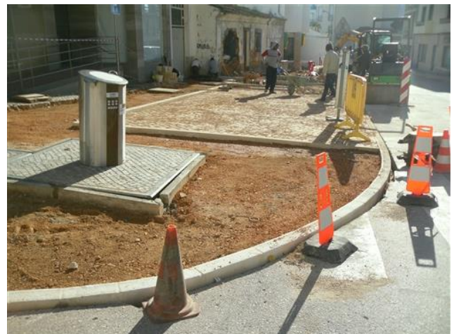
Figura 4.118 – Compactação da camada de tout-venant
