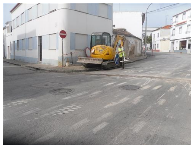
Figura 4.73 – Corte do betuminoso no cruzamento
