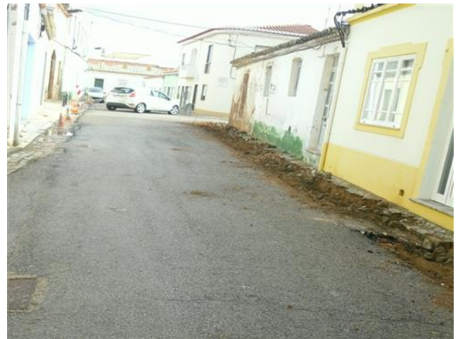
Figura 4.46 – Remoção de material betuminoso e calçada
