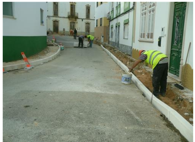
Figura 4.66 – Continuação de colocação de lancil
