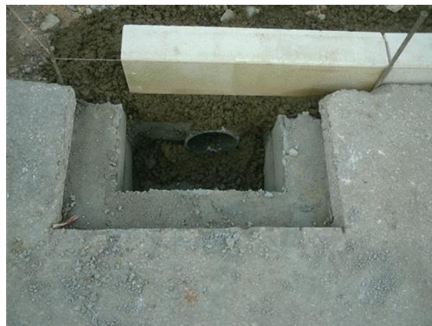
Figura 4.131 – Colocação de lancil
