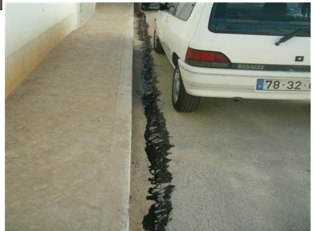
Figura 4.68 – Cola de fixação do betuminoso
