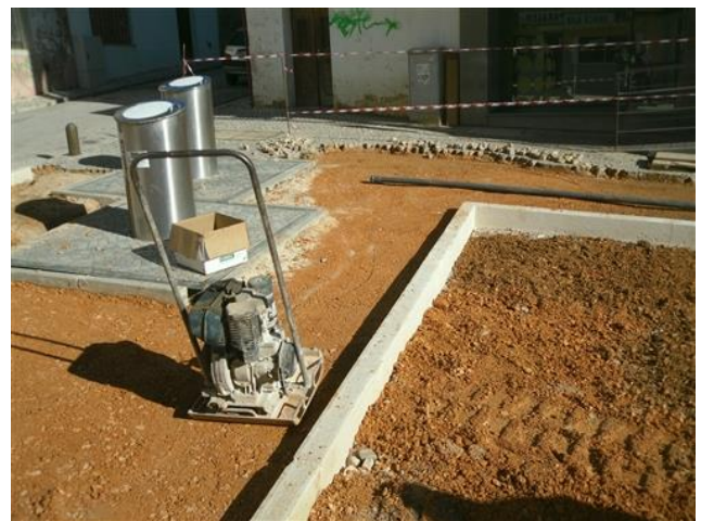
Figura 4.117 – Camada de tout-venant
