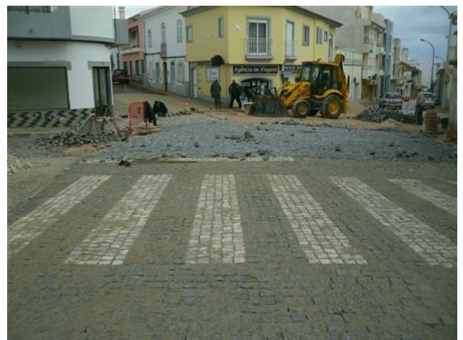
Figura 4.190 – Execução das passadeiras em calçada
