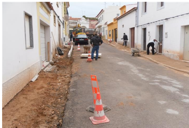
Figura 4.33 – Continuação dos trabalhos na Rua do Cirurgião
