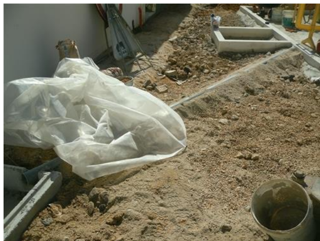
Figura 4.15 – Reencaminhamento de pluvial
