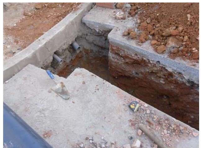
Figura 4.121 – Ligação ilhas ecológicas / sumidouro
