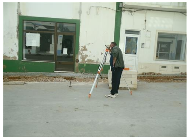
Figura 4.142 – Utilização do nível
