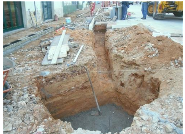
Figura 4.151 – Escavação e colocação de betão de limpeza
