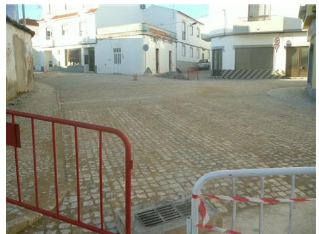
Figura 4.192 – Finalização dos trabalhos no cruzamento
