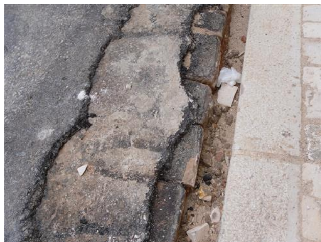
Figura 4.106 – Situação de betuminoso sobre calçadas
