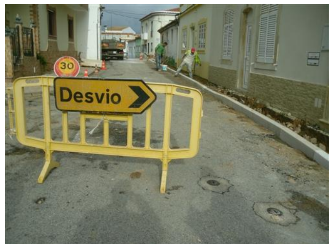
Figura 4.48 – Colocação de lancis
