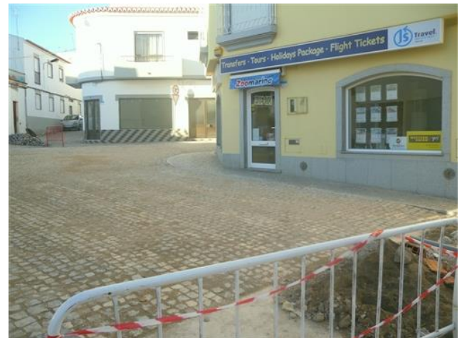
Figura 4.191 – Finalização dos trabalhos no cruzamento
