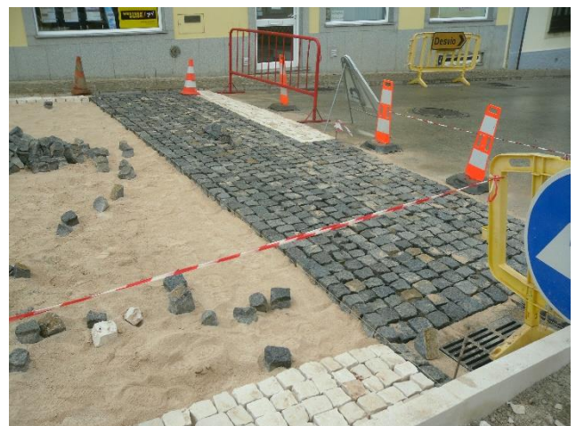
Figura 4.82 – Primeiras fiadas de calçada
