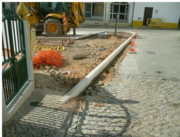
Figura 4.12 – Colocação de lancil nas bacias
