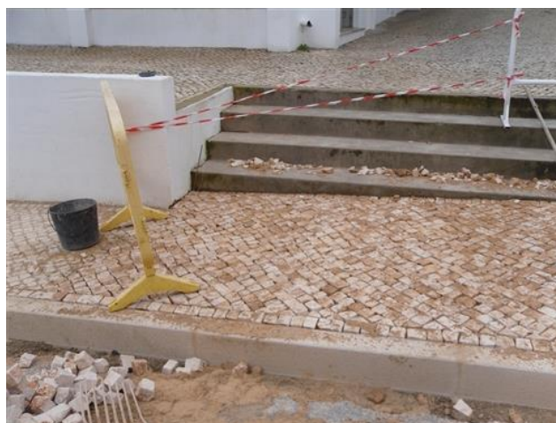
Figura 4.105 – Remoção do último degrau
