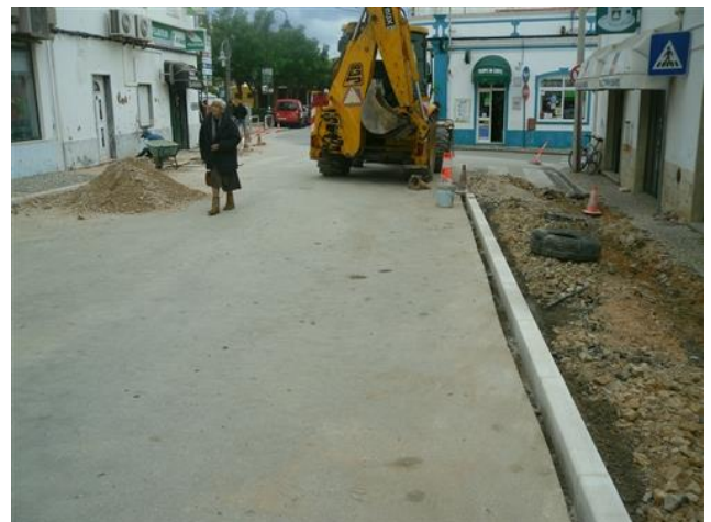
Figura 4.145 – Continuação dos trabalhos
