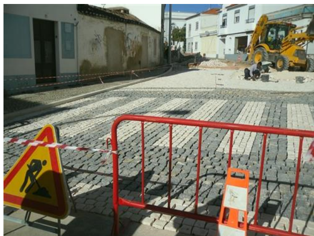
Figura 4.84 – Trabalhos de Calçadas no cruzamento
