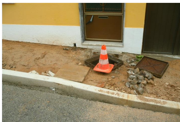
Figura 4.34 – Transição do rebaixamento com peça longa
