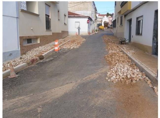
Figura 4.36 – Início de execução de calçadas
