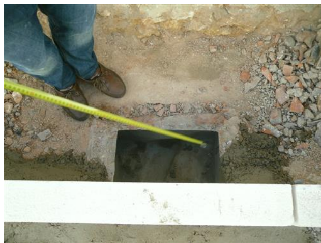
Figura 4.25 – Lancil passando sobre a caixa de esgotos
