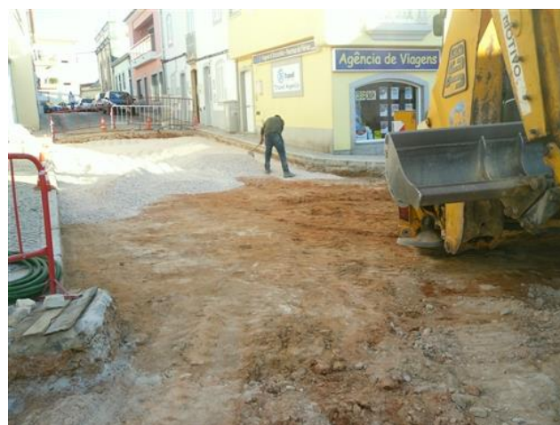
Figura 4.169 – Aplicação da 1ª camada de tout-venant
