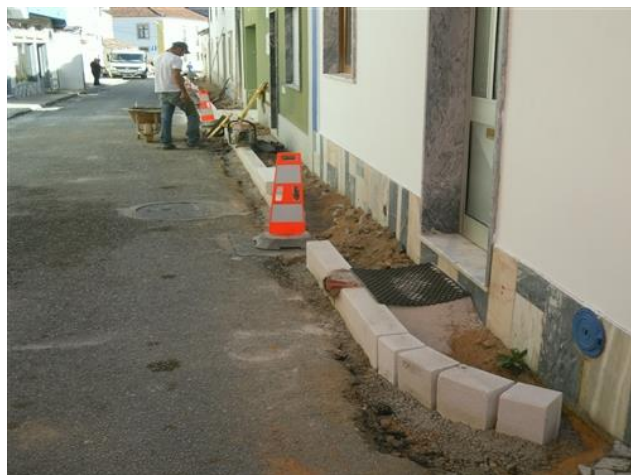
Figura 4.24 – Colocação de lancil
