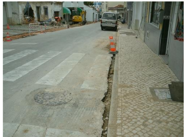
Figura 4.104 – Rampa metálica removida
