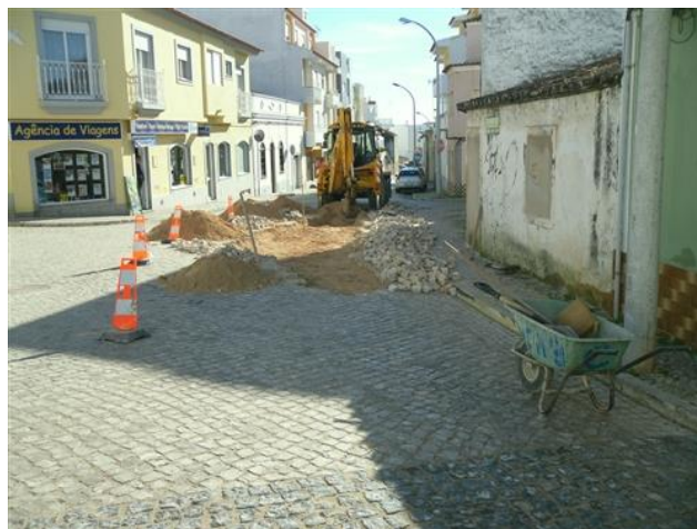
Figura 4.135 – Abertura de vala no cruzamento
