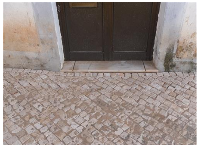
Figura 4.37 – Calçada sob a pedra de soleira
