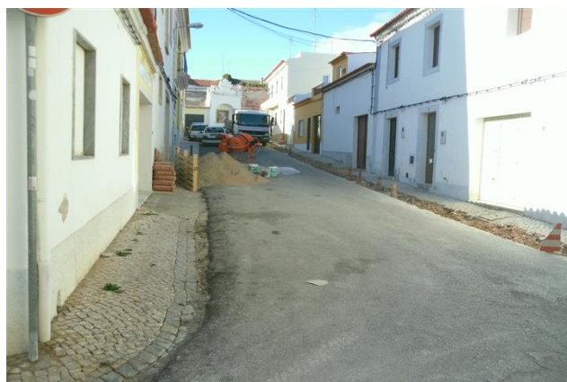
Figura 4.29 – Remoção de detritos
