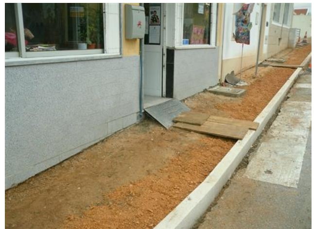
Figura 4.96 – Rampa metálica á entrada do comércio
