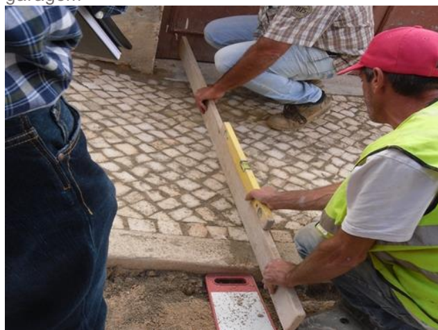
Figura 4.43 – Verificação da pendente
