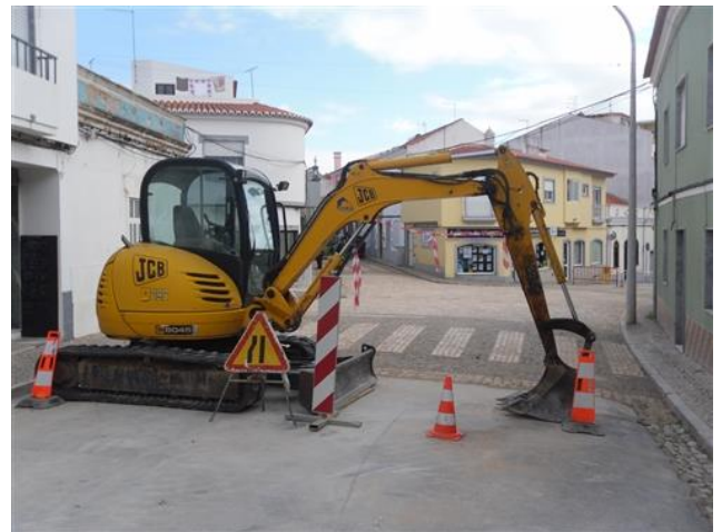
Figura 4.89 – Finalização dos trabalhos no cruzamento
