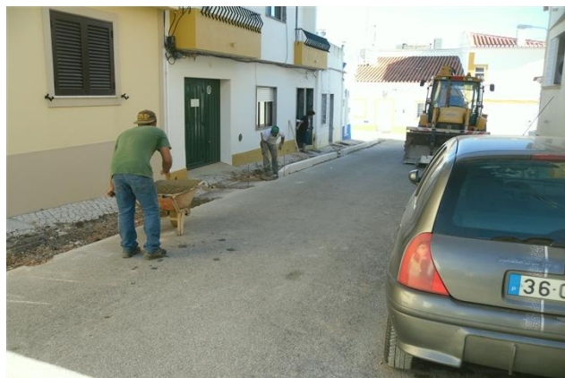
Figura 4.27 – Continuação dos trabalhos na Rua do Cirurgião
