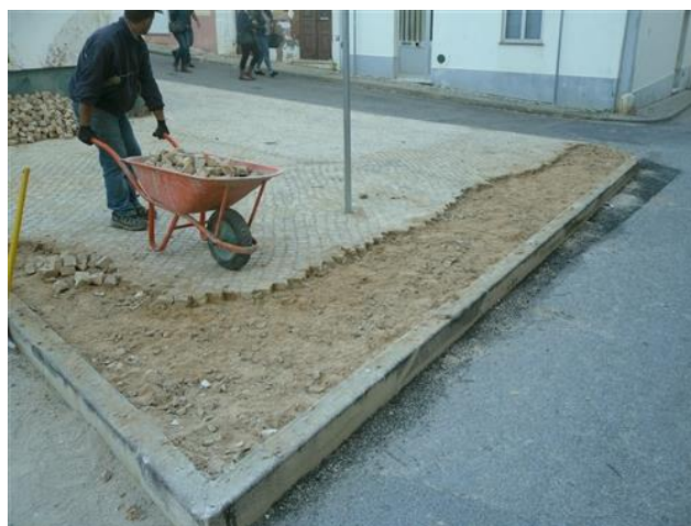
Figura 4.164 – Remoção de calçada
