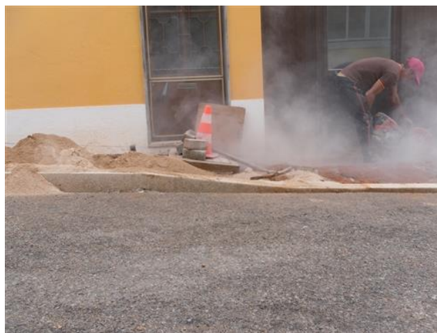
Figura 4.35 – Corte da pedra de soleira
