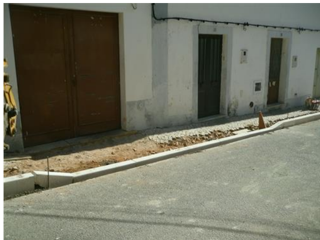
Figura 4.31 – Rebaixamento de lancil prolongado
