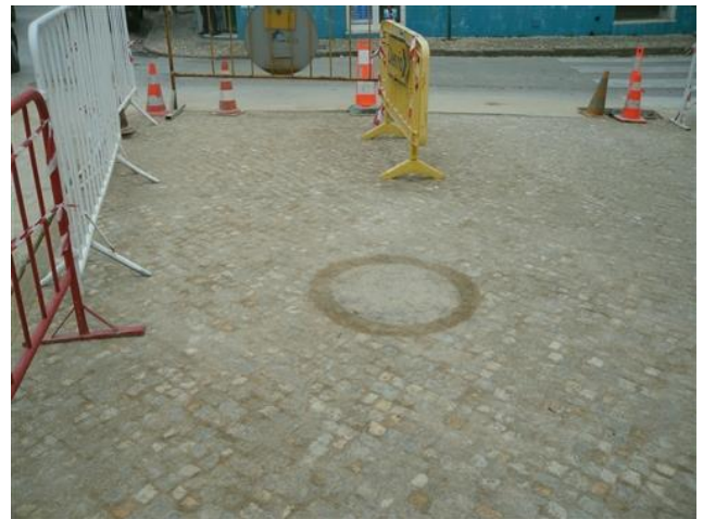
Figura 4.158 – Conclusão de calçadas
