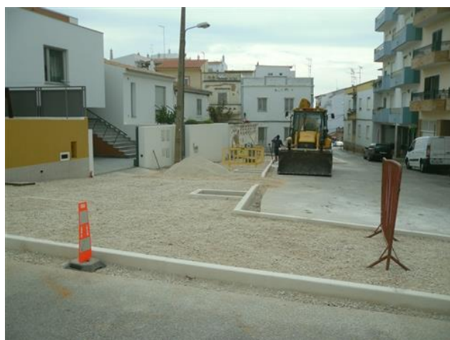
Figura 4.17 – Colocação do pó de pedra
