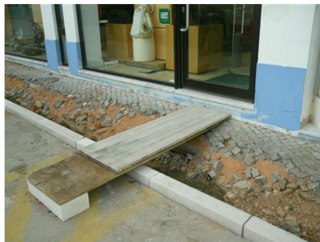
Figura 4.132 – Farmácia com dificuldade no acesso a pessoas com mob. reduzida.
