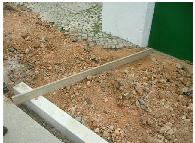
Figura 4.103 – Pendente para a entrada da garagem
