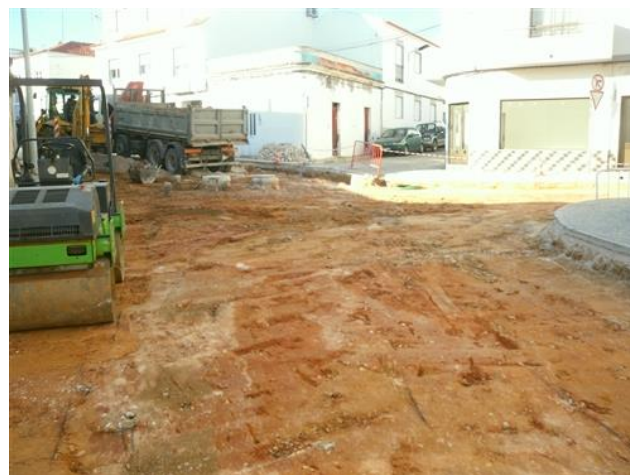
Figura 4.168 – Compactação do solo natural
