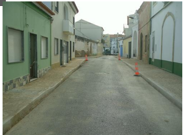
Figura 4.65 – Conclusão de calçadas
