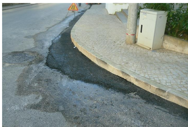
Figura 4.174 – Remate do betuminoso na curva
