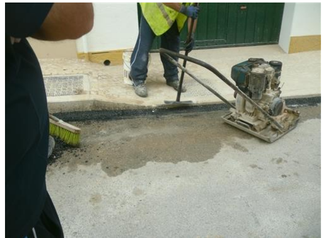
Figura 4.86 – Compactação manual e mecânica
