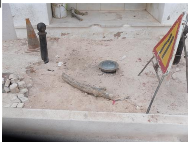
Figura 4.74 – Iluminação do Passo
