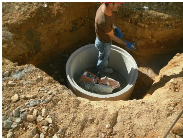
Figura 4.153 – Colocação da base da caixa de ligação
