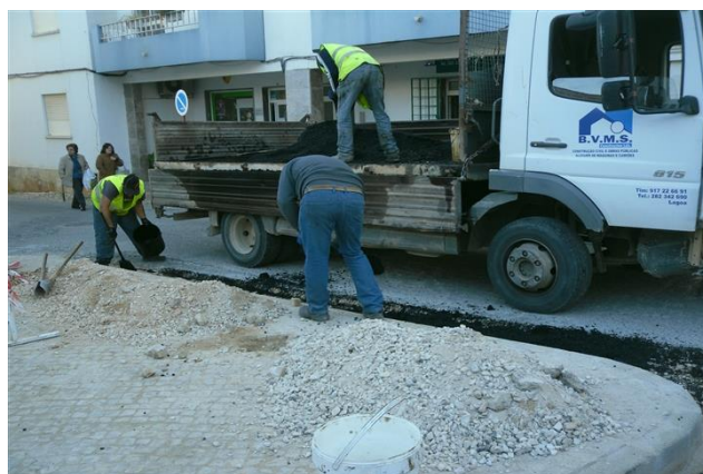
Figura 4.175 – Aplicação do remate de betuminoso nas bacias do Largo da Carlota
