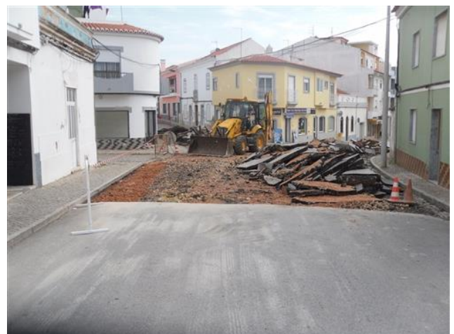
Figura 4.79 – Remoção das camadas de betuminoso
