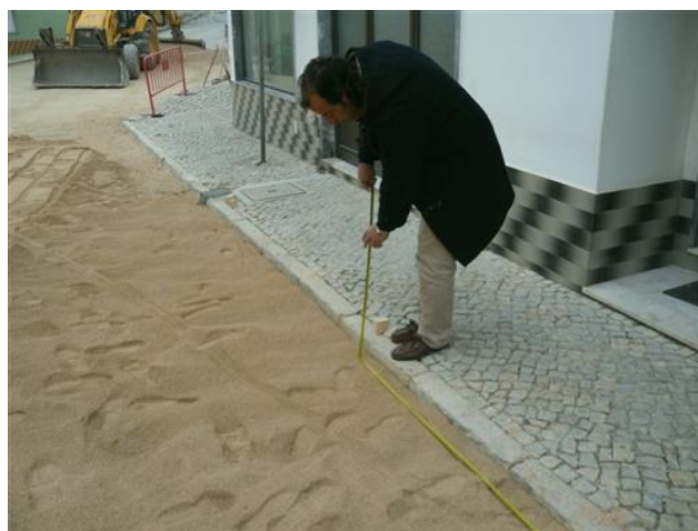
Figura 4.179 – Marcação das passeadeiras
