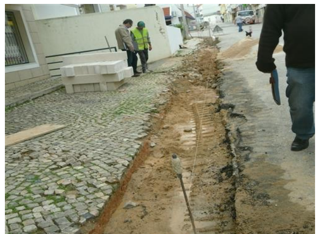
Figura 4.94 – Trabalhos em frente ao edf. Recife
