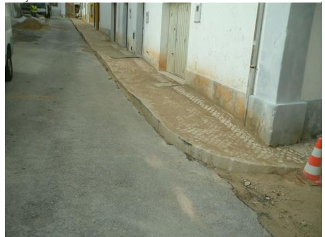
Figura 4.47 – Lavagem do pó de pedra na Rua do Cirurgião
