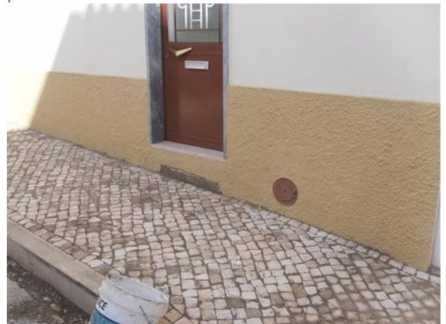
Figura 4.40 – Remoção do degrau rudimentar
