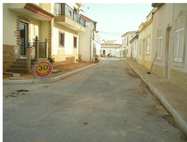
Figura 4.57 – Finalização de calçadas
