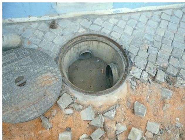
Figura 4.138 – Inspeção visual da caixa
