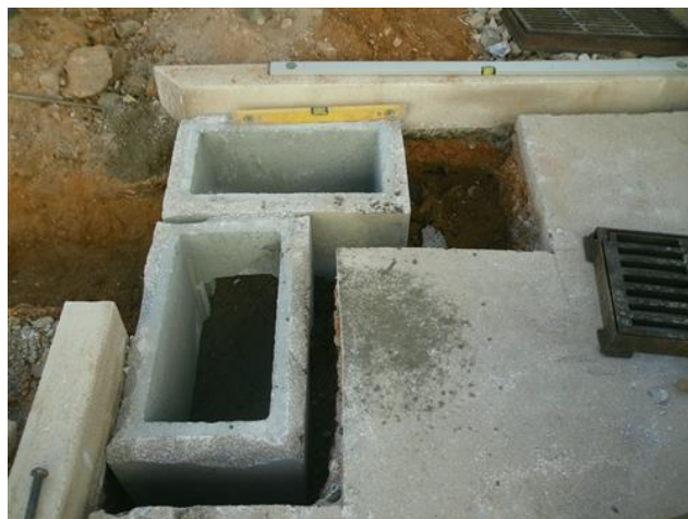
Figura 4.152 – Execução de sumidouros
