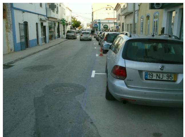
Figura 4.187 – Pinturas dos lugares de estacionamento
