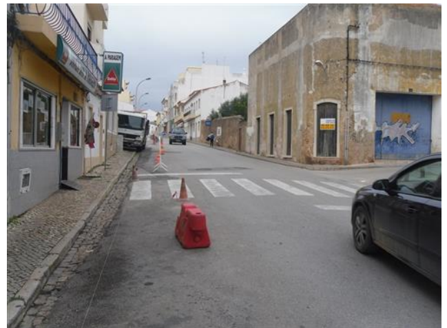
Figura 4.92 – Esticamento do fio
