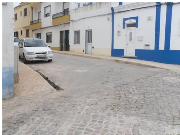
Figura 4.75 – Confinamento de passeios
