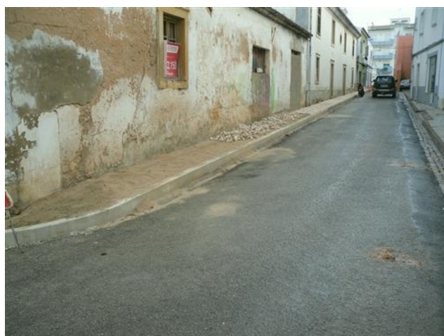
Figura 4.32 – Colocação de calçada
