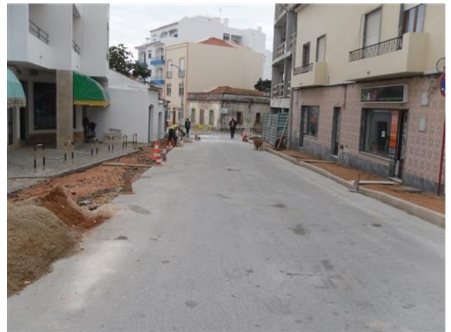
Figura 4.98 – Trabalhos em ambos lados do arruamento
