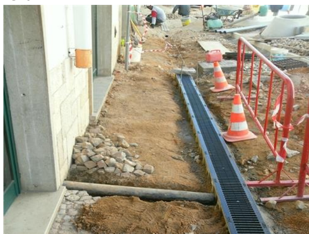
Figura 4.154 – Ligação de pluvial á caleira
