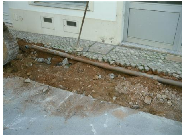
Figura 4.134 – Tubagem de pluvial a ser recolocada
