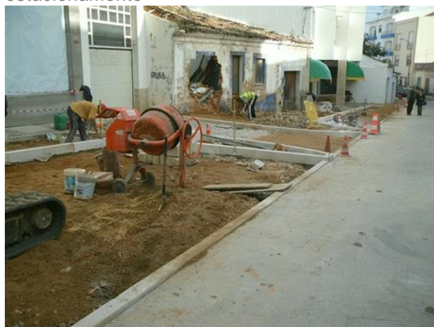
Figura 4.112 – Continuação dos trabalhos
