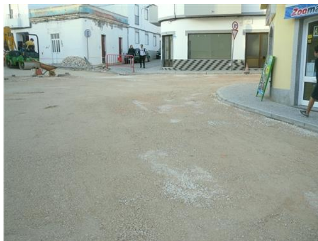
Figura 4.177 – Compactação da 2ª camada de tout-venant
