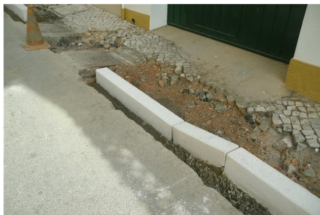
Figura 4.28 – Rebaixamento de lancil à entrada da garagem
