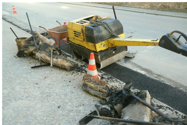
Figura 4.173 – Aplicação e compactação de betuminoso
