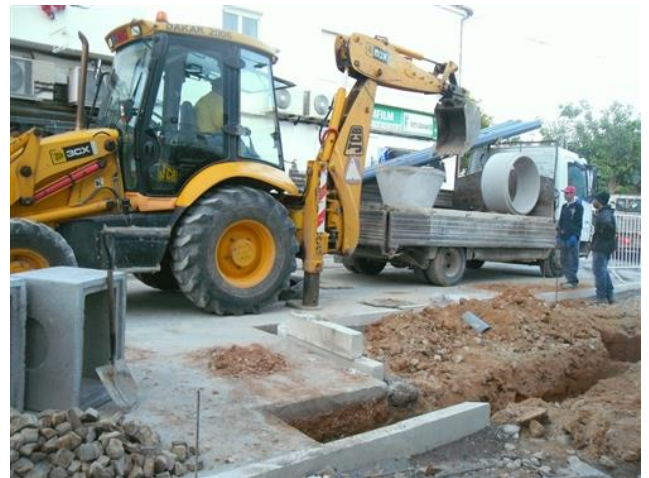
Figura 4.150 – Peças da caixa de ligação de ramais
