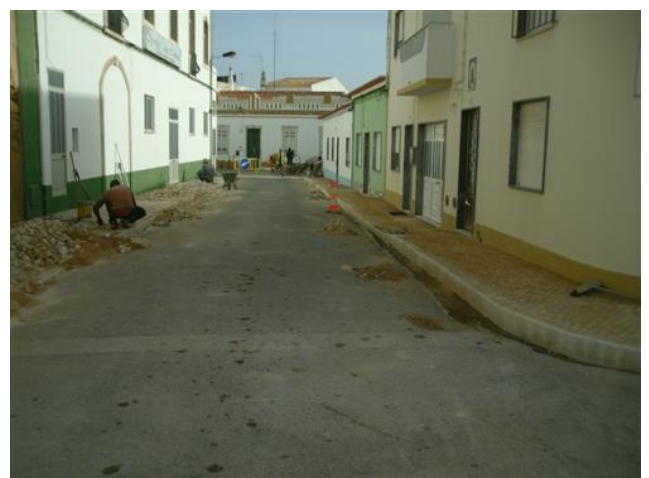
Figura 4.60 – Remoção de pavimento
