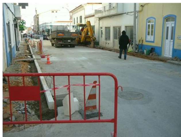
Figura 4.130 – Intervenção a ambos lados da rua
