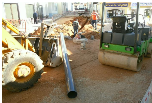
Figura 4.170 – Escavação de valas para ligação de pluviais
