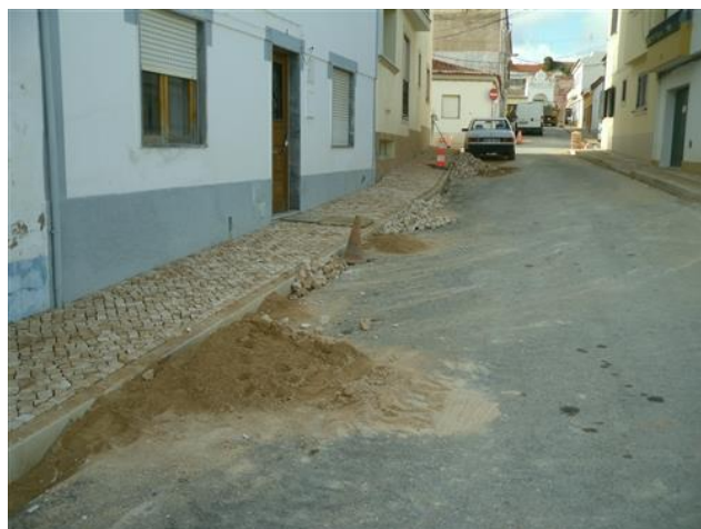
Figura 4.51 – Entulho disperso nas várias ruas
