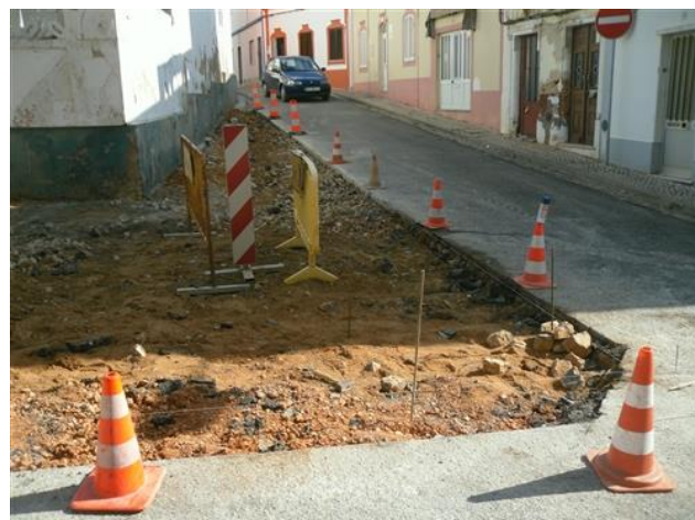
Figura 4.10 – Remoção de detritos
