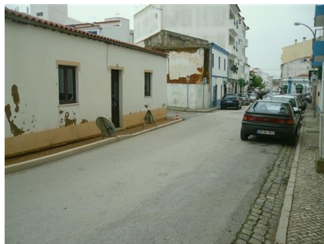
Figura 4.109 – Rebaixamento brusco de lancil
