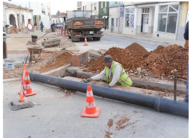
Figura 4.123 – Ligação do sumidouro a rede pluvial
