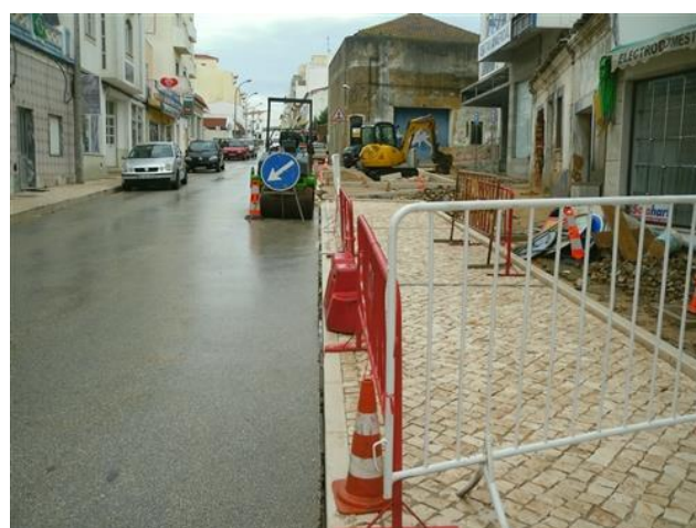
Figura 4.116 – Ausência de trabalhadores em obra
