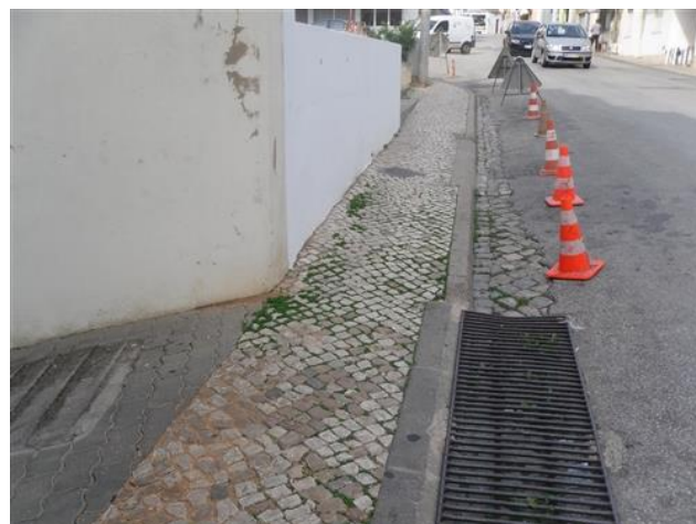
Figura 4.72 – Grelha metálica á entrada da garagem
