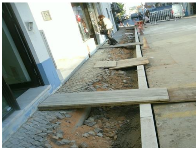
Figura 4.137 – Tubagem sob a calçada
