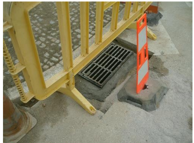
Figura 4.125 – Execução do sumidouro
