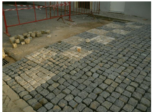
Figura 4.189 – Colocação das pedras das passadeiras
