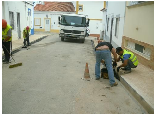
Figura 4.87 – Aplicação da cola de fixação
