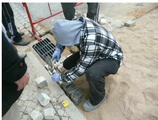
Figura 4.181 – Colocação do padrão em xadrez
