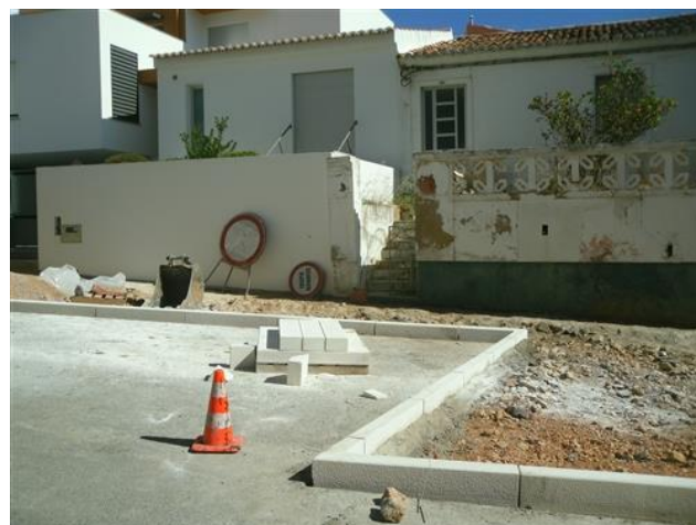
Figura 4.11 – Colocação de Lancil no estacionamento
