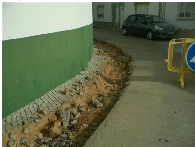
Figura 4.62 – Alastramento dos trabalhos para a rua Tomé B. de Queirós
