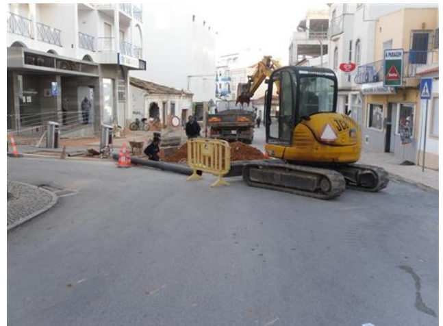
Figura 4.119 – Escavação de vala
