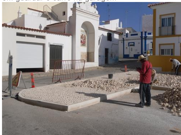
Figura 4.22 – Suspensão temporária dos trabalhos de calçadas em frente a garagem
