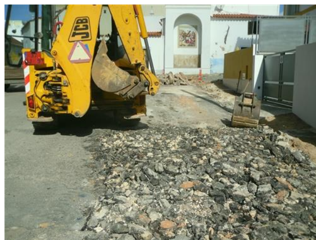
Figura 4.9 – Remoção de Pavimento
