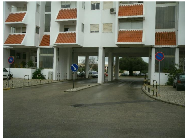
Figura 4.185 – Arcos desobstruídos de viaturas
