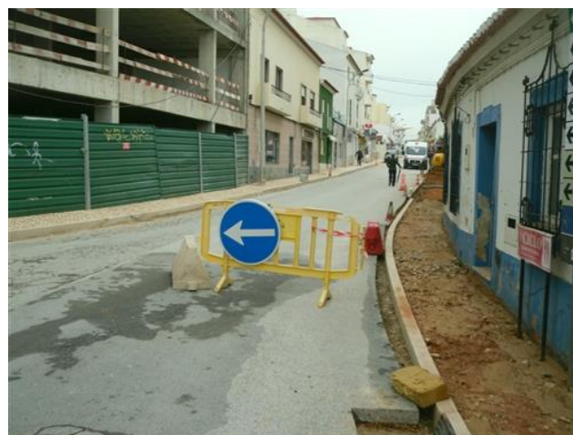
Figura 4.108 – Desvio de trânsito
