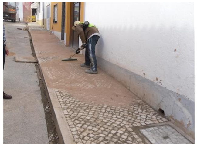
Figura 4.41 – Espalhamento do pó de pedra
