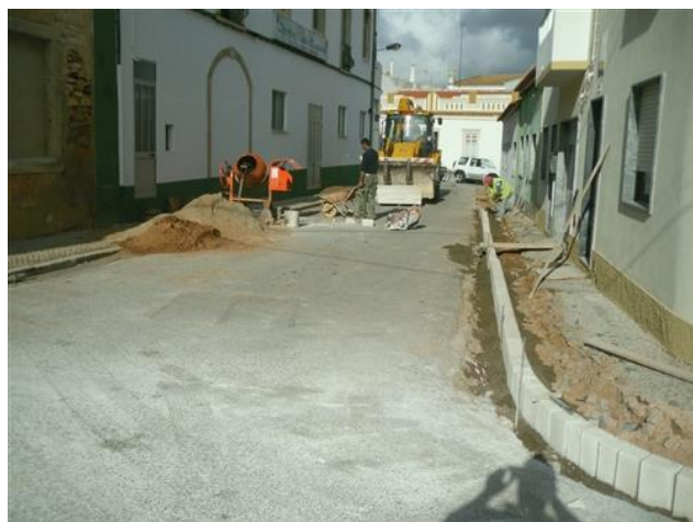
Figura 4.50 – Continuação dos trabalhos de colocação de lancil
