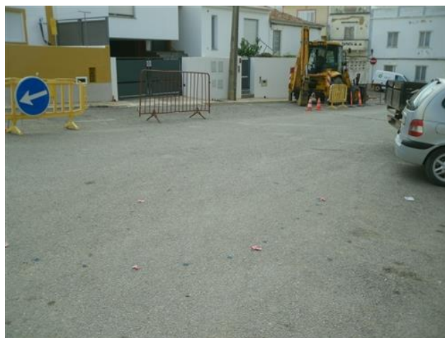
Figura 4.7 – Colocação de baias, sinais e pinos
