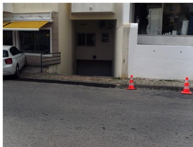
Figura 4.71 – Entrada da garagem do edf. Recife
