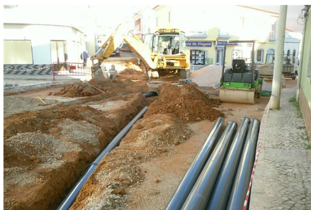
Figura 4.171 – Colocação de tubagens
