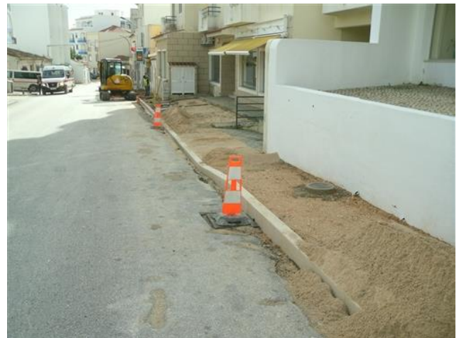
Figura 4.95 – Trabalhos de colocação de lancil
