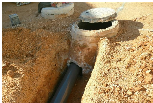
Figura 4.172 – Ligação de tubagem à caixa de ramais
