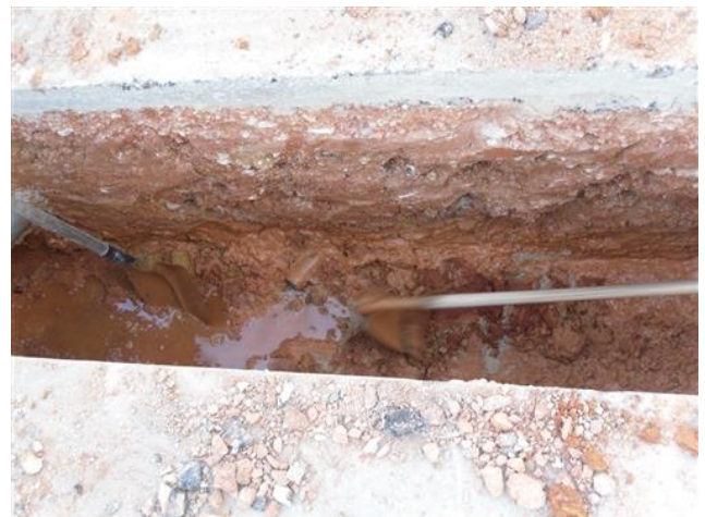
Figura 4.120 – Tubagem danificada
