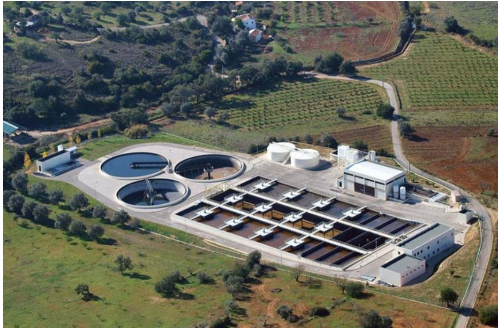
Figure I.8. The Area view of Albufeira Poente WWTP (Águas do Algarve, 2025)
