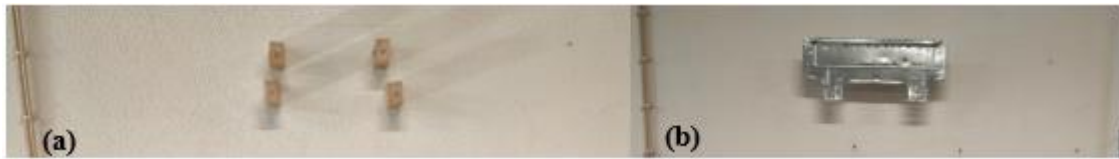
Figura 3.7 - Estrutura de suporte da unidade interior- (a) suporte da chapa; (b) suporte da unidade
