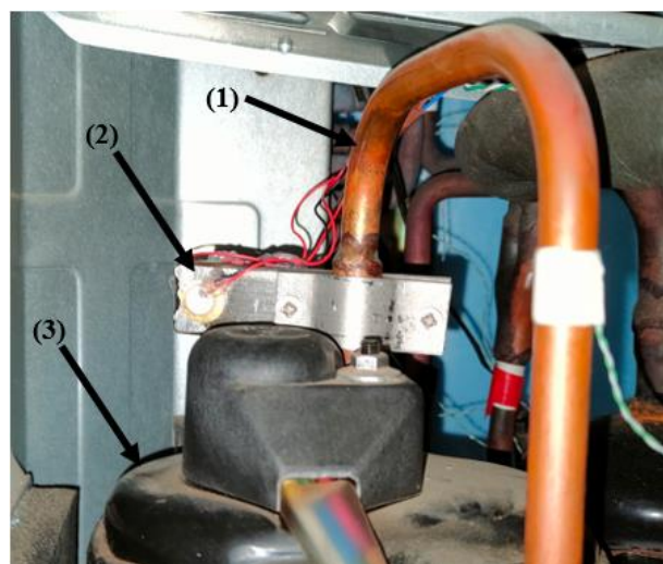
Figura 4.10 - Montagem do perfil no tubo de saída do compressor
