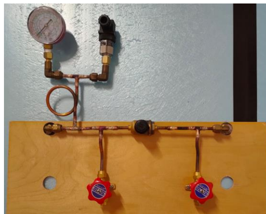
Figura 3.12 - Montagem final das válvulas 1, 2 e 3
