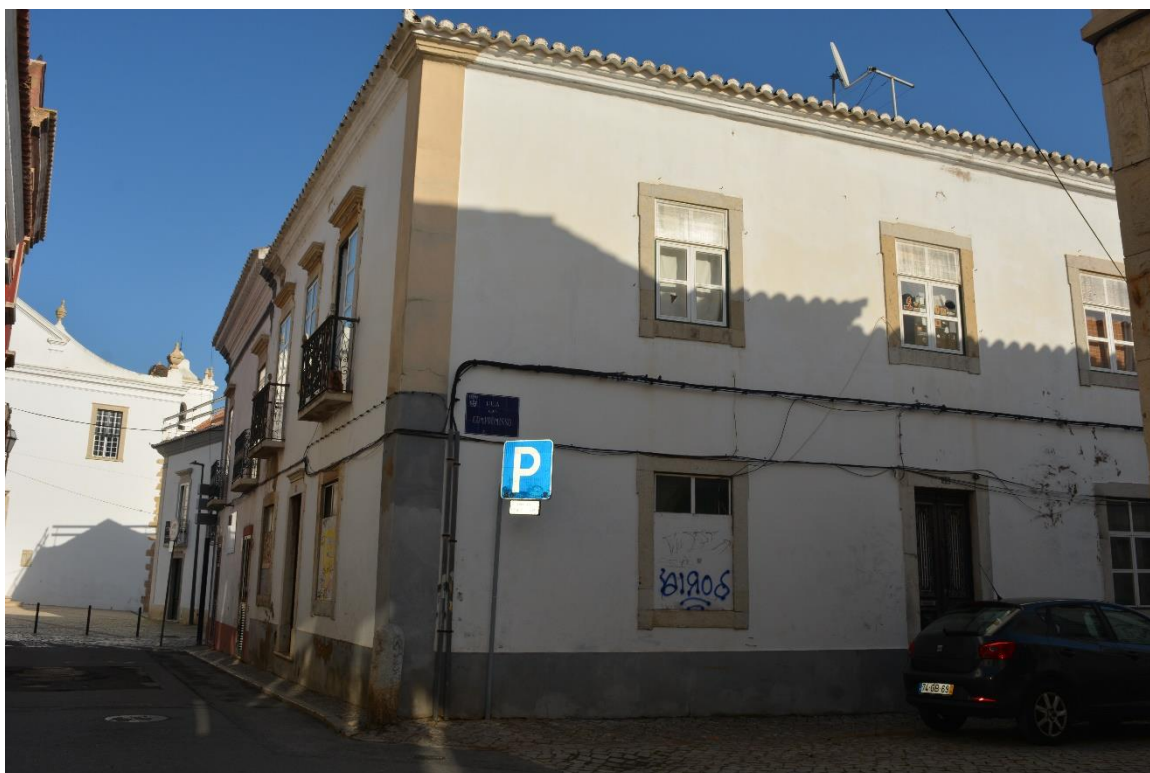
Figura 4.19 - Fotografia do estado atual do imóvel alvo de estudo
