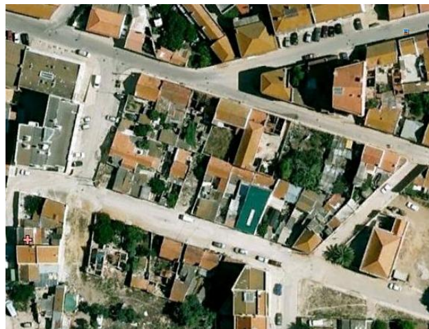
Figura 3A.8 – Quarteirão muito degradado (delimitado pelas ruas Alfredo Lima, General G. Freire e Travessa da Beneficência) (Fonte: Google Earth)
