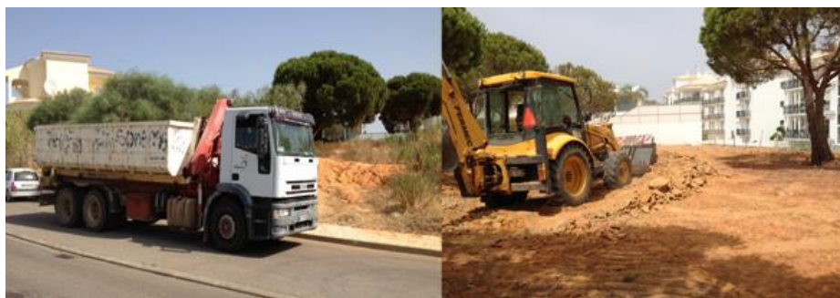
Figura 4.14 – .Limpeza do espaço de intervenção (fotos do autor).
