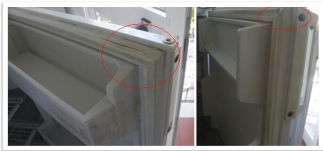
Figura 6 – Frigoríficos do 2º andar da Residência Masculina Ferragial com as borrachas das portas danificadas
