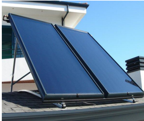
Figura 3.4 - Coletor plano [36]
