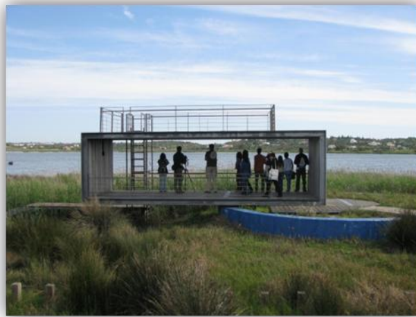
Fig. 64 e 65 - Observatório de aves actual
