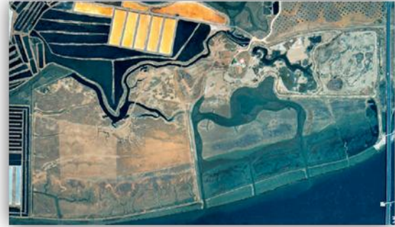
Fig. 49 – Área após intervenção (Fonte: APEA, 2004)
