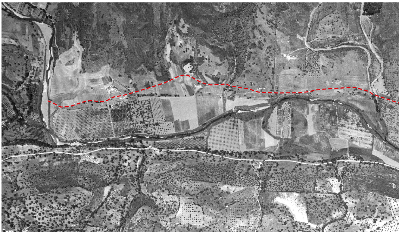
Anexo 9.24 - Parte do eixo viário correspondente à actual estrada N397 é deslocado mais a norte impondo-se sobre os terrenos agrícolas (anteriores à construção deste novo troço).
