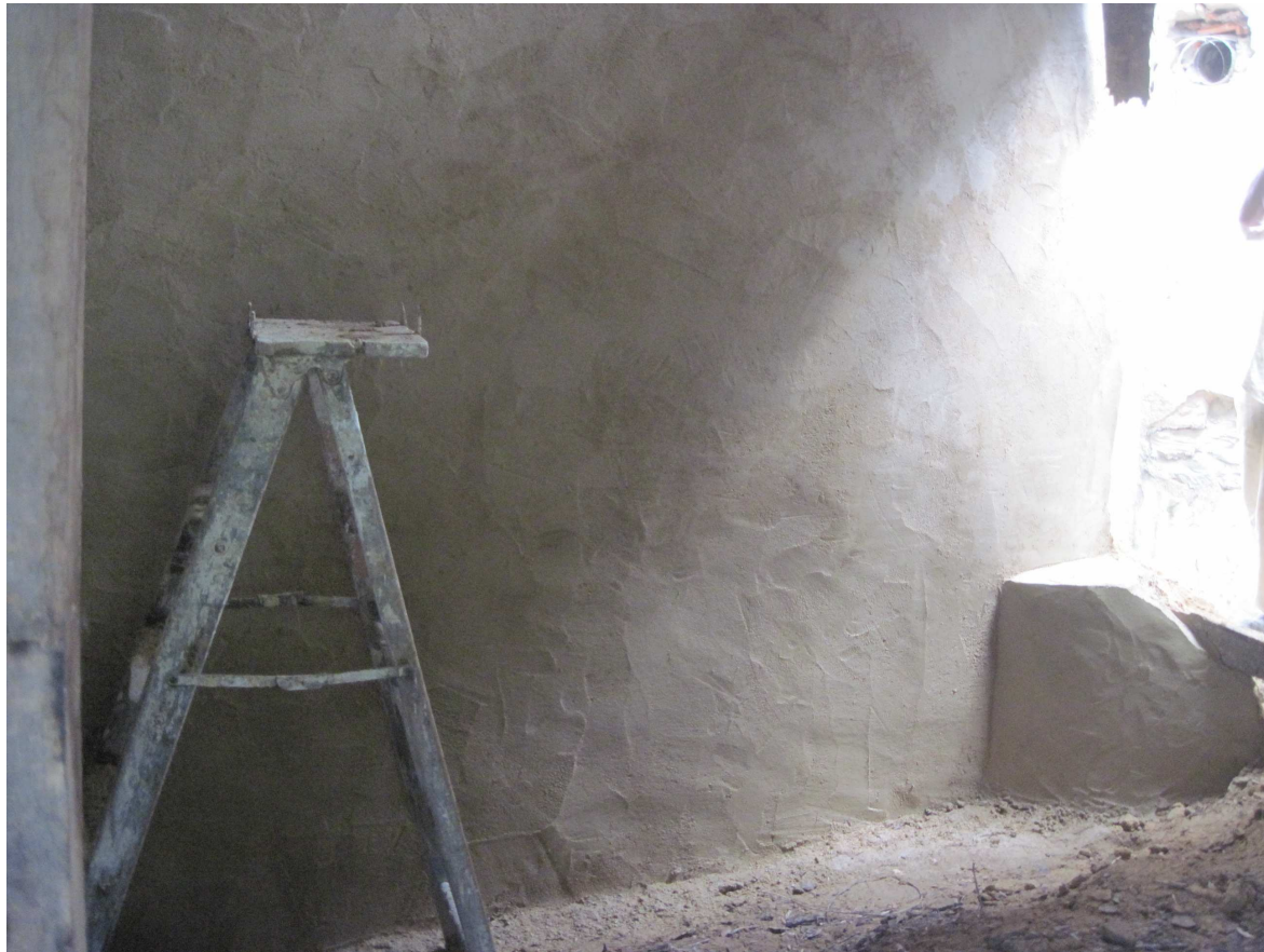
17h26 – vista da parede após aplicação do novo reboco de areia e cal.
