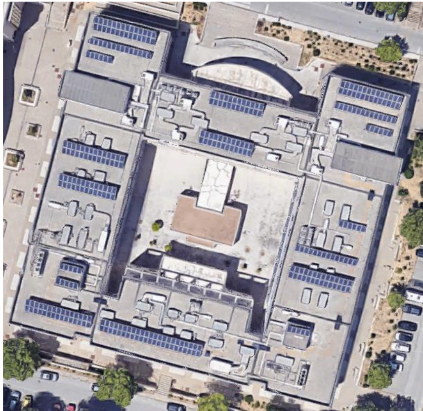
Figura 36 - Edifício 8 do Campus de Gambelas. [62]
