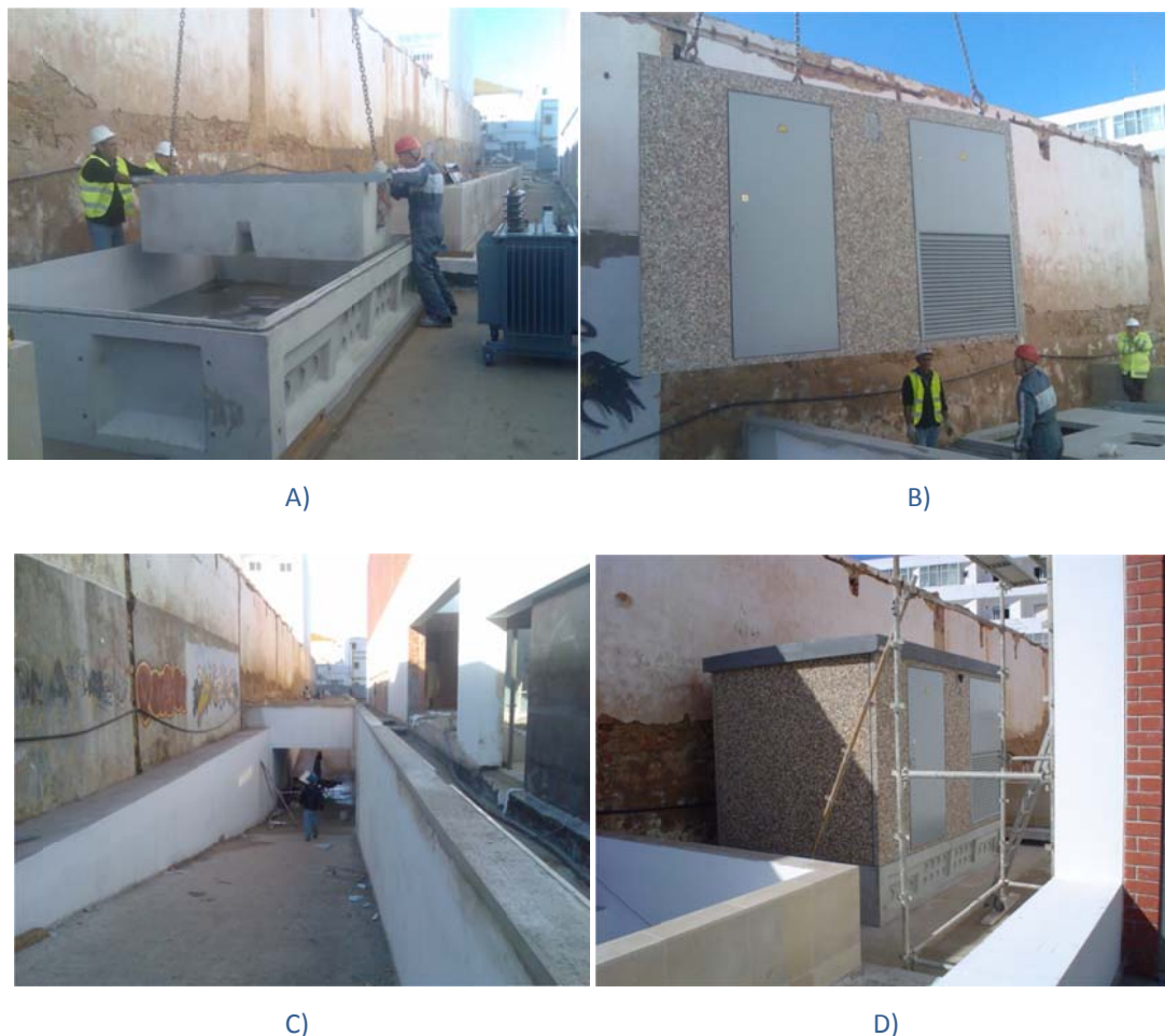
Figura 3-2 – Imagens da instalação do posto de transformação público.
