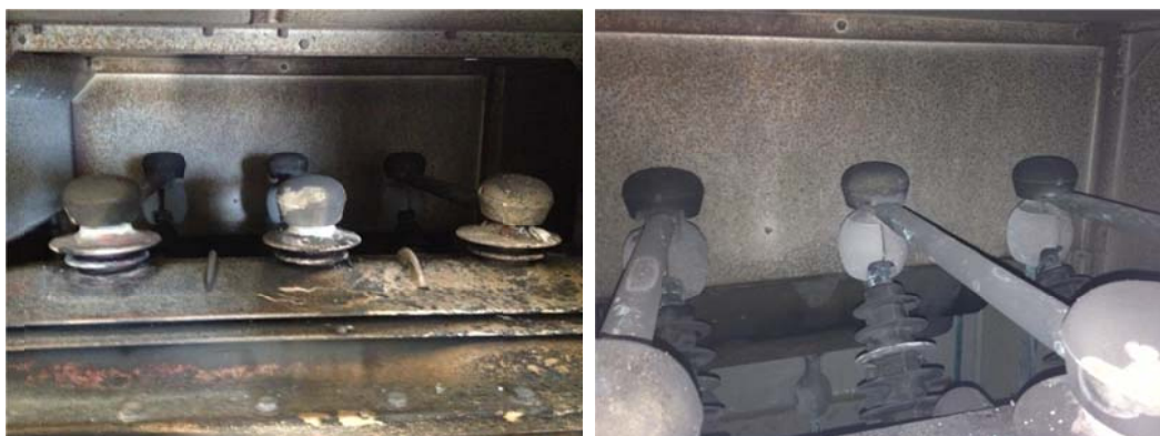
Figura 3-53 – Fotos tiradas antes de uma manutenção no Posto de transformação do Largo da Feira de Santa Iria
