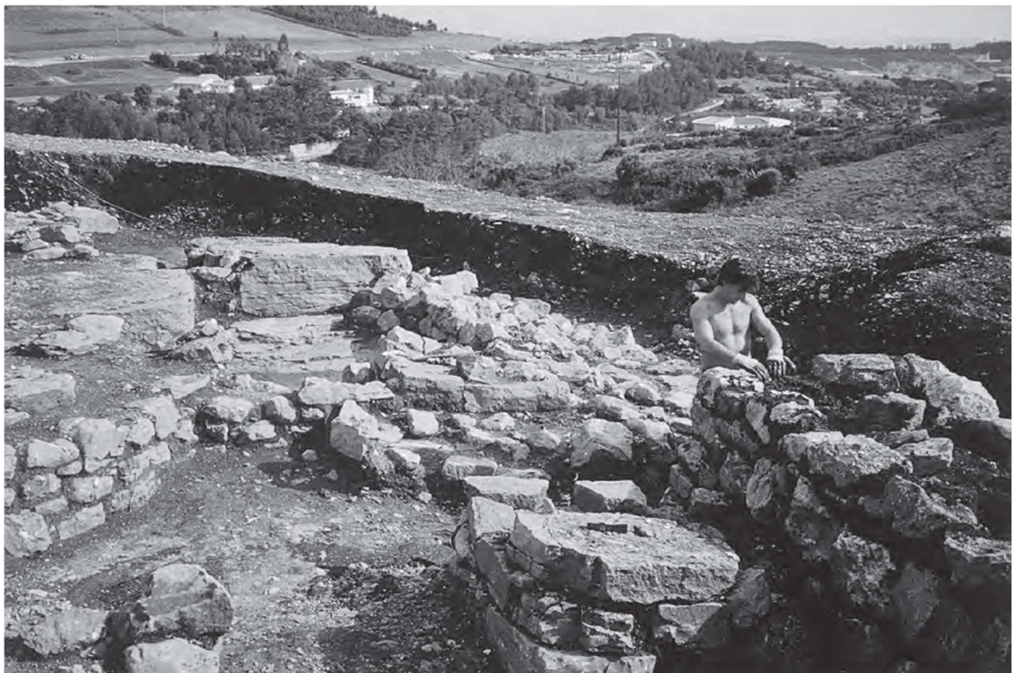
Figura 21. Povoado pré-histórico de Leceia, trabalhos de consolidação, alteamento e restauro de estruturas arqueológicas realizados em 1992. Fonte: Cardoso 2022.
