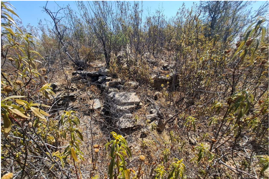
Figura 59. Vista parcial da estrutura murária entre a torre 1 e a torre 2. Autoria: A. Romão 2024.
