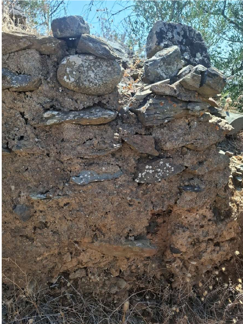
Figura 61. Juntas e assentamentos executados com argamassa cimentícia, muro entre a torre 9 e a torre 3. Autoria: A. Romão 2024.
