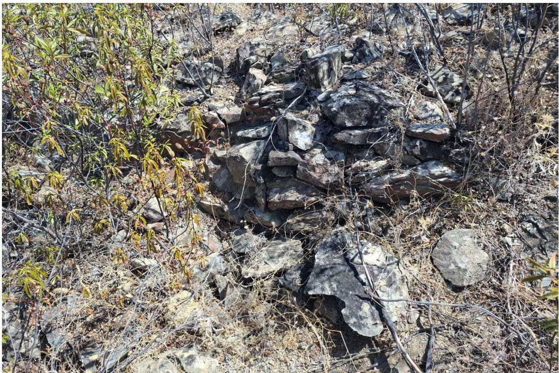
Figura 64. Derrube parcial da estrutura torre 7. Aatoria: A. Romão 2024.
