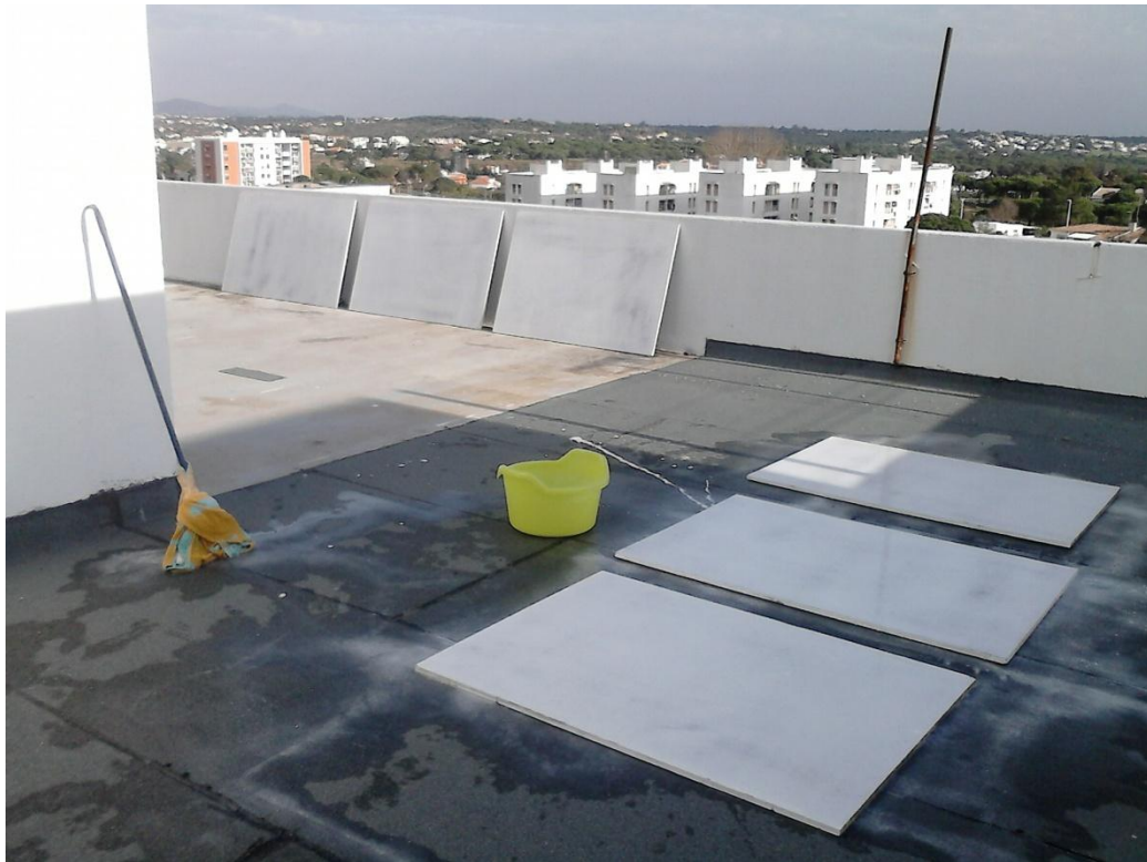
Figura 33 – Lavagem das Placas.
