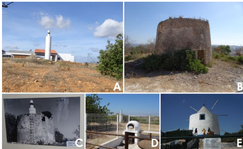
Figura 6.1. Exemplos de vértices geodésicos (V.G) nos cerros elevados na periferia do Planalto do Escarpão, alguns deles aproveitando moinhos de vento como suporte. A: Cerro do Ouro (144 metros); B: Cerro de S. Vicente (175 metros); C: Cerro do Moinho do Leitão (154 metros)-moinho antigo (1980); D: posição atual do V. G. Do Moinho do Leitão (foi deslocado), em relação ao moinho atual (fotografia E).
