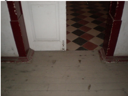
Fig.178 - Da sala de visitas(salão nobre) para o corredor – casa Gama Lobo
