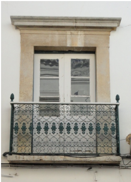
Fig.19 -Janela de sacada de lintel recto e cimalha saliente.O gradeamento de ferro forjado da sacada é idêntico ao gradeamento da casa nobre Gama Lobo de Loulé.
