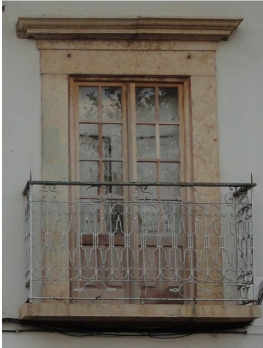
Fig. 2 - Janela de sacada de lintel recto e cimalha saliente
