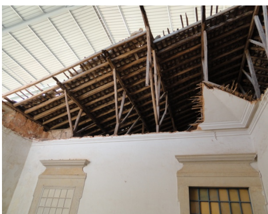
Fig.193 - Cobertura sobre a escadaria- casa Azevedo e Silva
