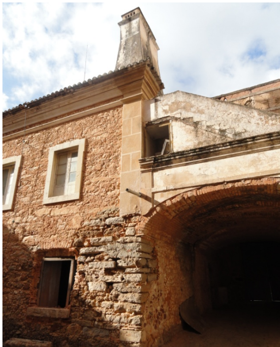
Fig.187 -1 e 2 -Cunhal (reforçado) do pátio interior – casa Gama Lobo
