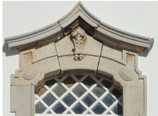
Fig.126 - Igreja do Carmo (Diogo Tavares) 1742. Repare-se no mesmo tipo de recorte relevado da cantaria da casa nobre Azevedo e Silva.
