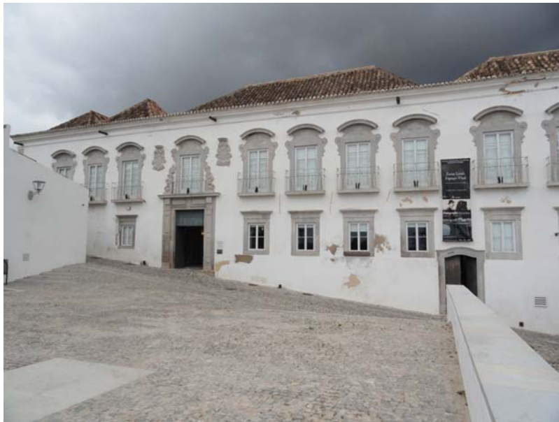
Fig.5 -Casas da Galeria, edifício remodelado no séc. XVIII, que apresenta doze janelas de sacada agrupadas em três conjuntos, com portal encimado por janela localizado lateralmente. “Para reforçar a falsa centralidade da articulação portal/janela, o conjunto é enquadrado por duas placas de talha esculpida como se fossem pedra de armas...” 32 . A cada vão de sacada corresponde uma janela de peitoril de duplo lintel e cornija saliente.
