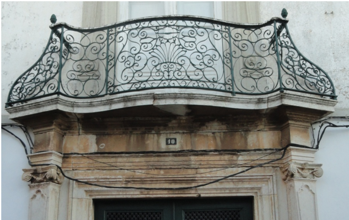
Fig.29 -O balcão da janela que encima o portal central, é mais sobressaído que os outros restantes e apresenta recorte ondulado. A mesma janela apresenta ombreiras laterais por volutas estilizadas e o portal pilares-estípites perspectivados, como no portal da Igreja de S. Francisco.
