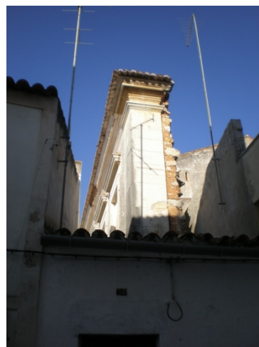
Fig. 74 -Fachada falsa e empena nascente da casa Azevedo e Silva
