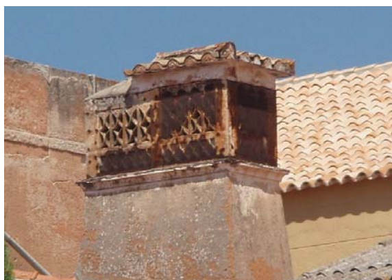
Fig.198 – Chaminé da casa Gama Lobo
