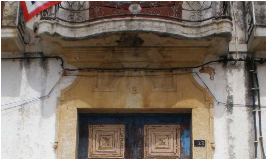
Fig.45 -O balcão da janela que encima o portal central, é mais sobressaída que as outras restantes e apresenta recorte ondulado. A cantaria do portal apresenta recorte relevado ainda do formulário de Diogo Tavares (por exemplo como na ermida de S. Sebastião em Faro ou outras igrejas de Tavira) mas num registo central diferente e mais próximo do desenho romano borromiano, aqui com roseta circular central.
