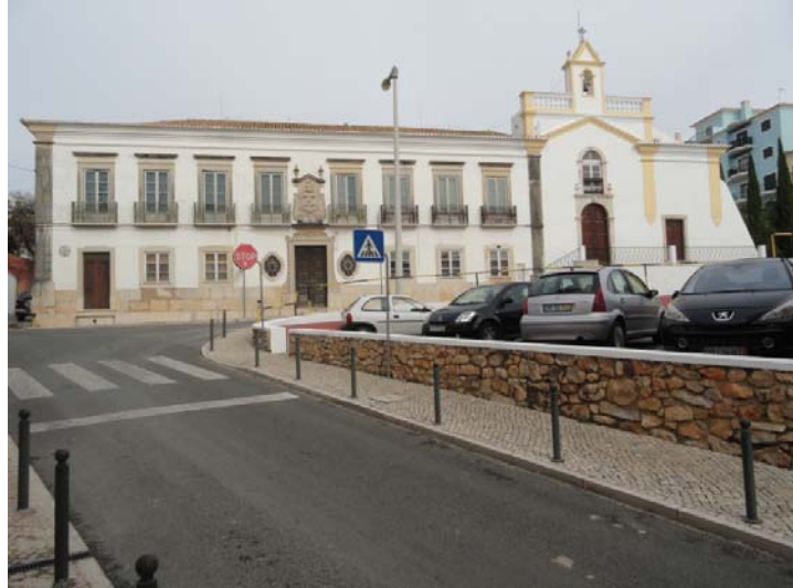
Fig. 47 - Edifício construído posteriormente e contíguo à mesma ermida.
