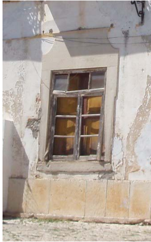
Fig. 154 -Azevedo e Silva- (1812-1826)Janela de peitoril do rés-do-chão
