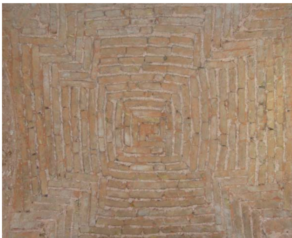
Fig.183- Abóbada sobre o patim do primeiro lance da escadaria
