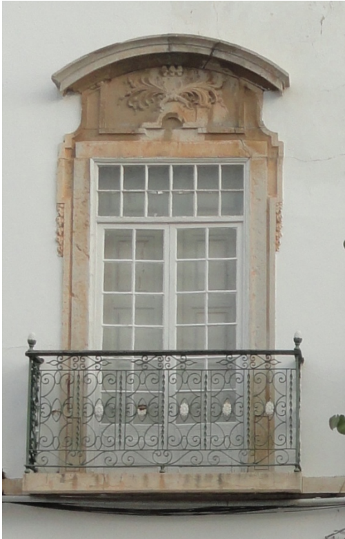
Fig.11 -Janela de sacada de lintel recto e cornija curva saliente. Repare-se no recorte da pedraria muito semelhante ao trabalho que Diogo Tavares elaborou nas cidades de Tavira e de Faro.
