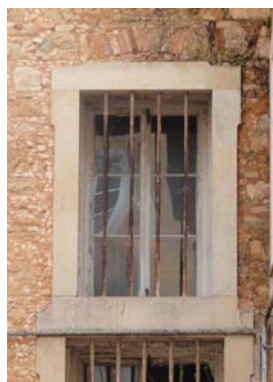
Fig.152 - Gama Lobo – janela do átrio que dá para o pátio interior
