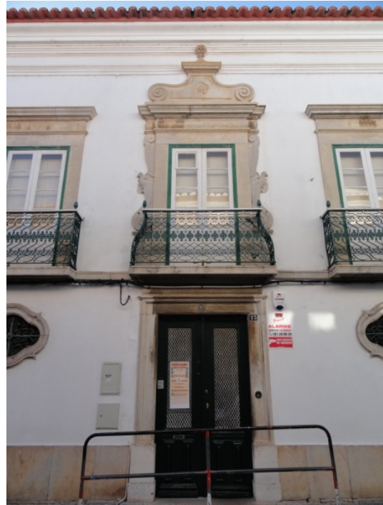
Fig.24-Portal encimado por janela de sacada conjugado com óculos de recorte barroco quadrilobado (assim como no óculo da capela na Horta do Ourives). O enquadramento de trabalho de cantaria é mais estilizado em relação ao que é apresentado na Casa das Açafatas, no entanto segue a mesma composição na janela superior.
