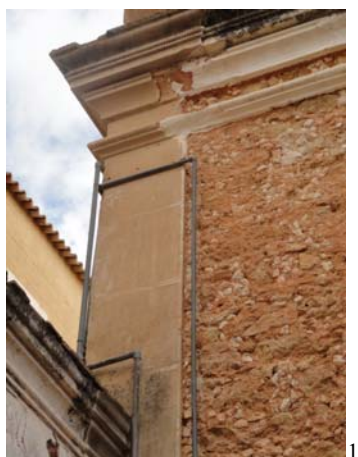
Fig.174– 1 e 2 – Pilastras em massa da casa Gama Lobo
