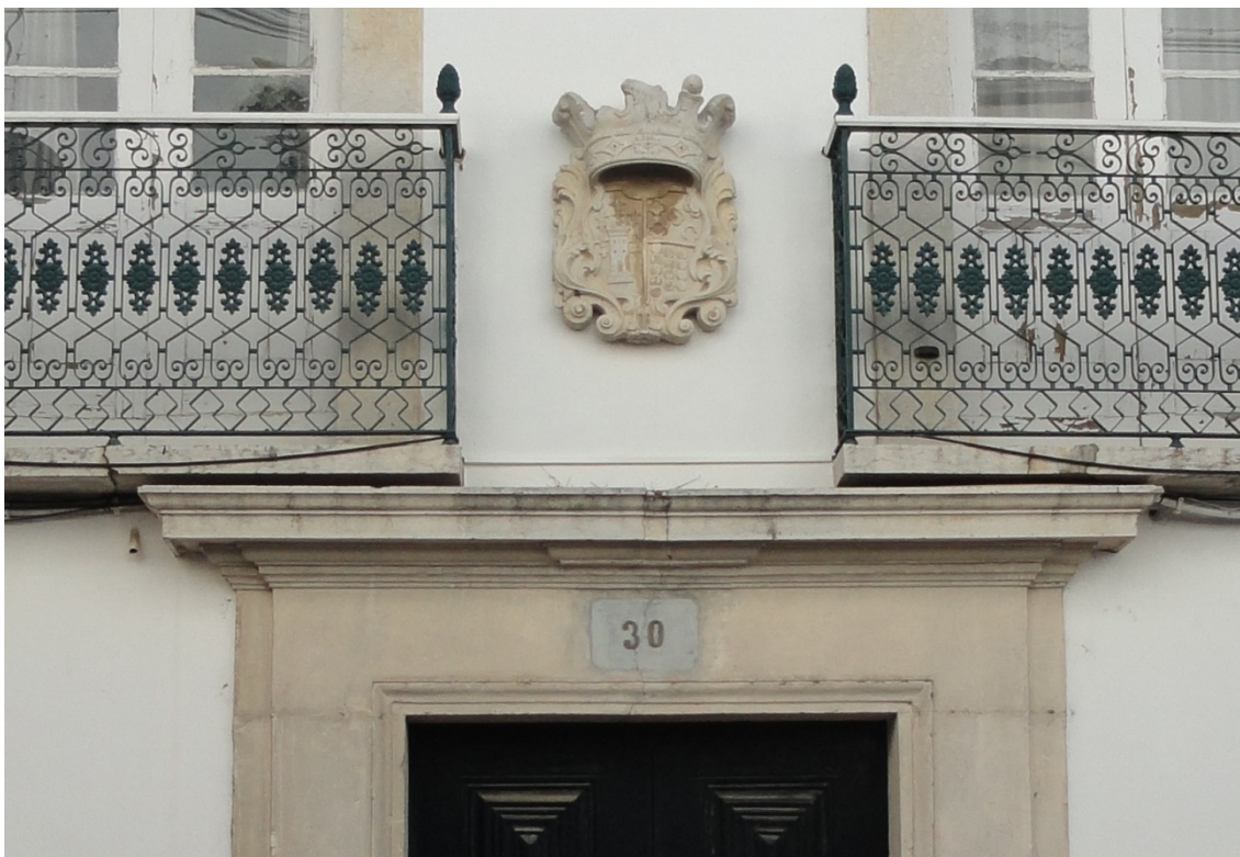
Fig.21 -Portal de grande sobriedade encimado por pedra de armas da família. A cimalha de cantaria é idêntica à cimalha das janelas de sacada do piso nobre.
