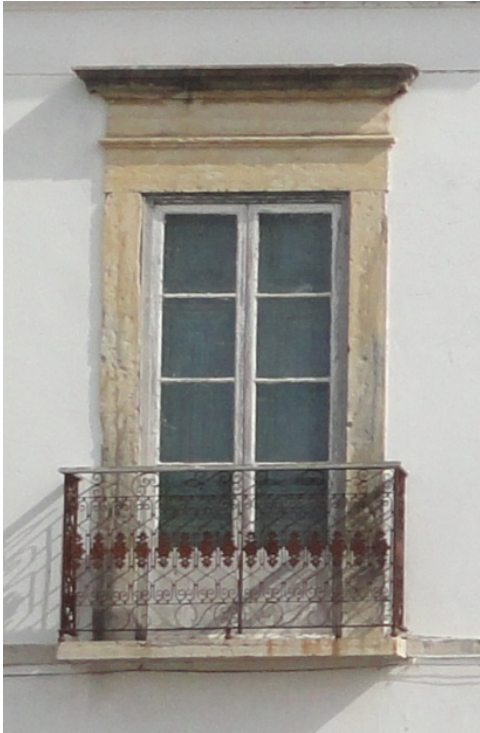
Fig.39 -Janela de sacada com duplo lintel e cimalha saliente.
