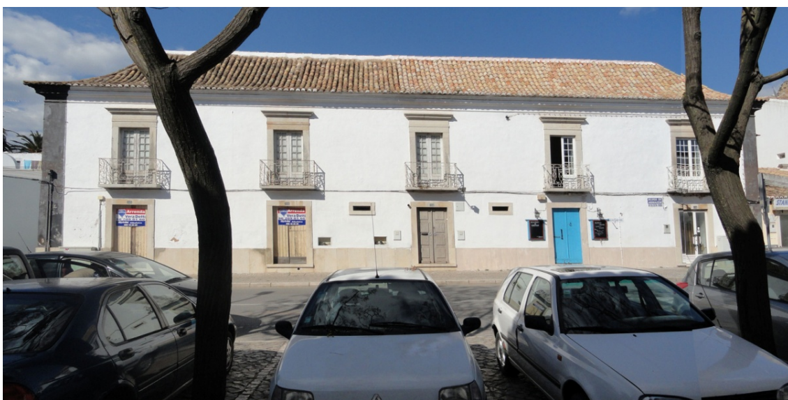
Fig.88 – Edifício de assumida arquitectura chã, em Loulé na Rua da Corredoura ( anterior ao terramoto de 1755).
