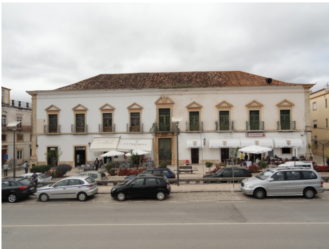
Fig.34 -Casa Grande de Silves ou casa nobre da família Duarte Machado, com portal central e janela de sacada encimada com pedra de armas.
