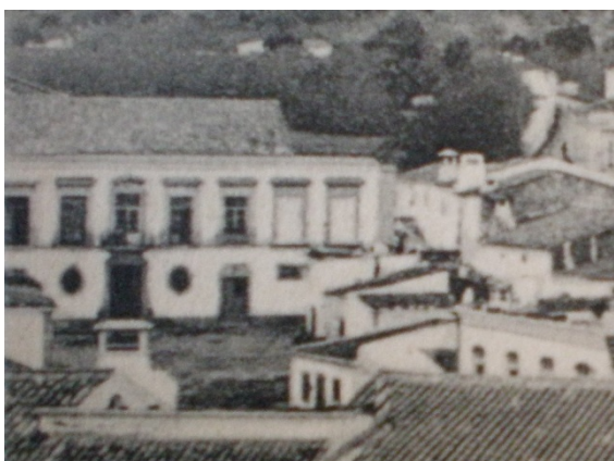
Fig. 68 -Foto (recorte) tirada do castelo (meados do séc.XX). Repare-se no casario envolvente do lado direito e à frente, que não parece tocar no edifício e é de um único piso e de construção pobre.
