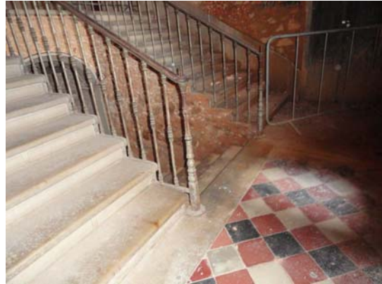
Fig.177-Patamar da escadaria – casa Gama Lobo
