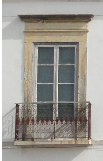
Fig.139 - Gama Lobo- janela do piso nobre Loulé
