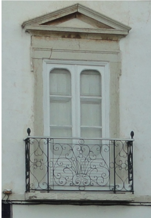
Fig.27 -Janela de sacada de duplo lintel com recortes laterais e cimalha saliente onde assenta frontão triangular.
