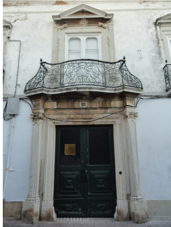
Fig.28 -Eixo de simetria marcado pelo conjunto portal-janela, conjugado com óculos rectangulares laterais.
