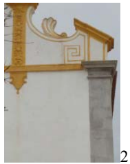
Fig. 112-1 e 2 Ermida de S. Sebastião -Tavira 1745 (trabalhos em massa de data posterior)
