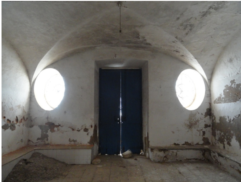
Fig.189- Entrada da casa Azevedo e Silva – abóbada de aresta.
