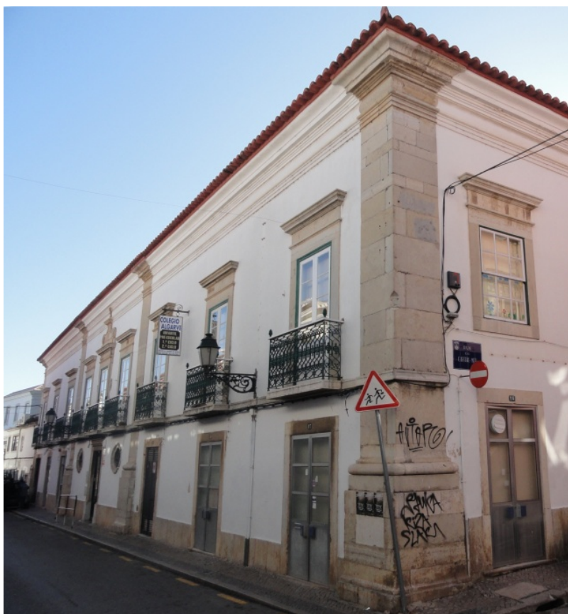
Fig.22 -O Solar do Capitão-Mor é constituído por um corpo central e dois laterais, cada corpo com três janelas, apresentando o corpo central um afastamento menor entre os vãos.
