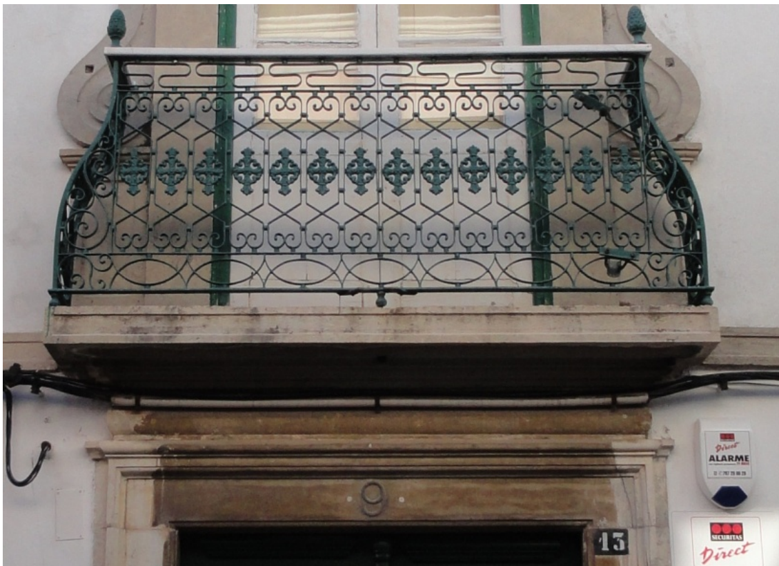
Fig.25 -O balcão da janela de sacada central, é igual aos restantes, apresentando, no entanto, ondulação na guarda de ferro forjado.
