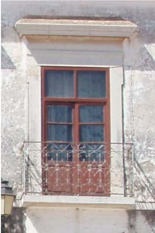
Fig.43 -Janela de duplo lintel com cimalha saliente e recorte nas ombreiras como nas casas nobres de Silves, Albufeira e Faro (palácio Bivar).
