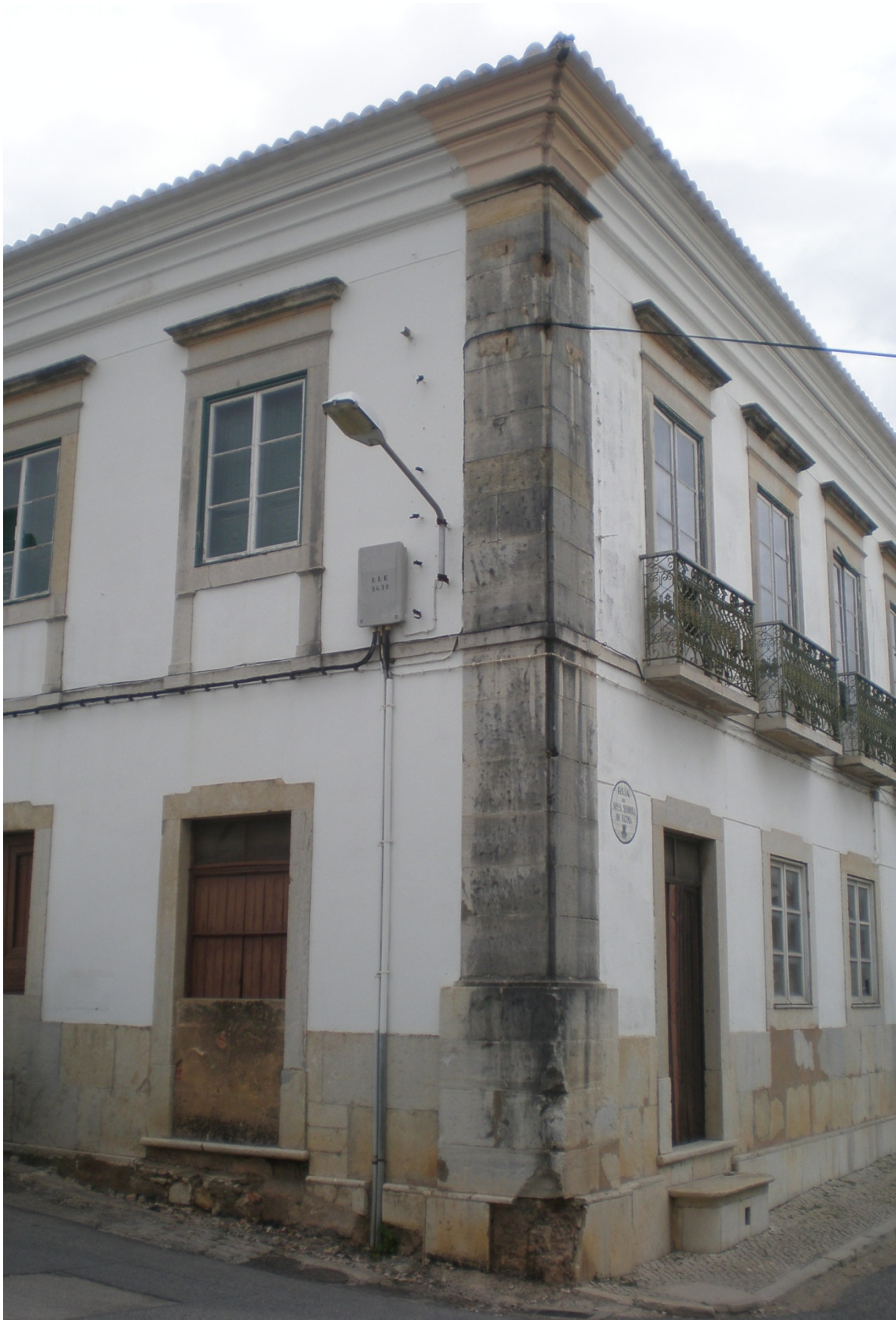
Fig.170 - Cunhal da casa nobre Gama Lobo. Repare-se no seu recorte, semelhante aos edifícios de Lisboa, com embasamento em ângulo curvo, e de desenho muito simplificado ( sem o tradicional elemento superior curvo “vaza”, nem “plinto” .
