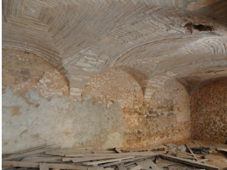
Fig.184- Abóbadas( de pedra caliça) no espaço denominado “celeiro” no rés-do-chão da casa Gama Lobo.
