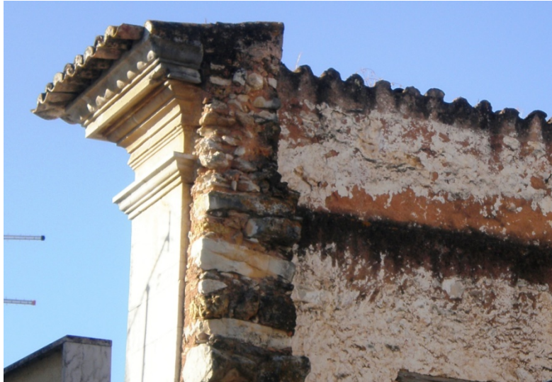
Fig.188- Alvenaria da parede exterior (parte falsa) – casa Azevedo e Silva
