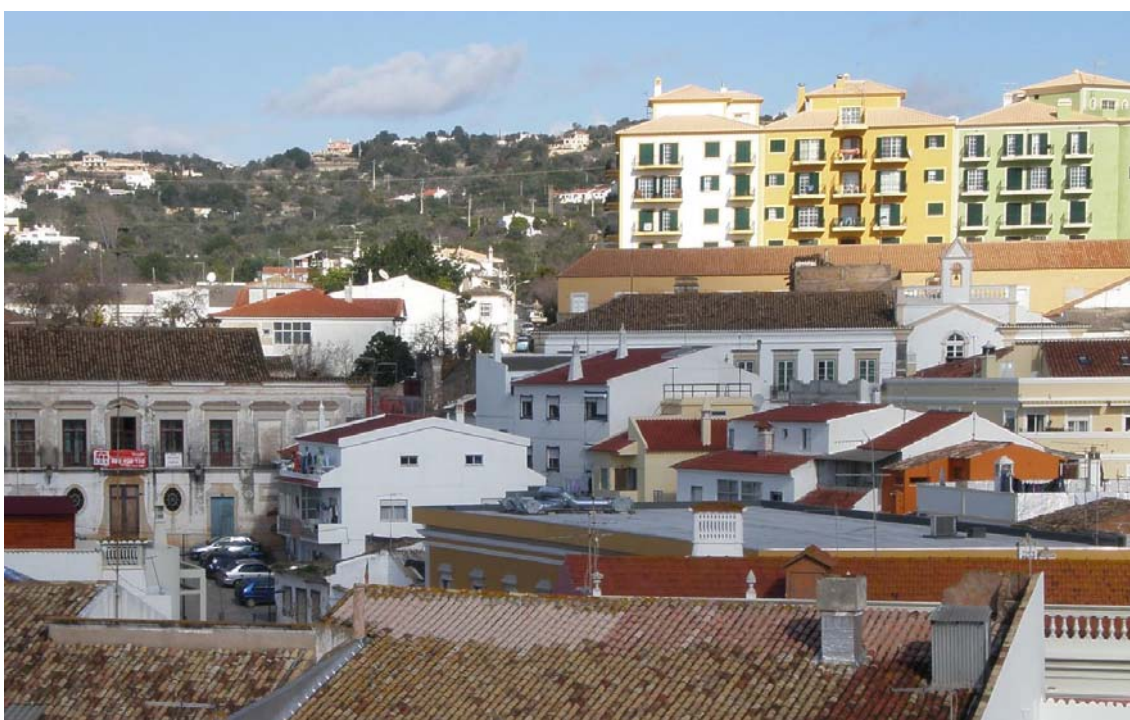
Fig.209 -A urbanização da Quinta da Boavista, no final do século XX, lateral e posterior à casa nobre Gama Lobo, resultou numa expansão planimétrica regulada do edificado, modificando no entanto o recorte da silhueta urbana do local, sem respeitar a envolvente patrimonial (Foto tirada do castelo em 2008).
