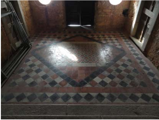
Fig.176 - Entrada casa Gama Lobo
