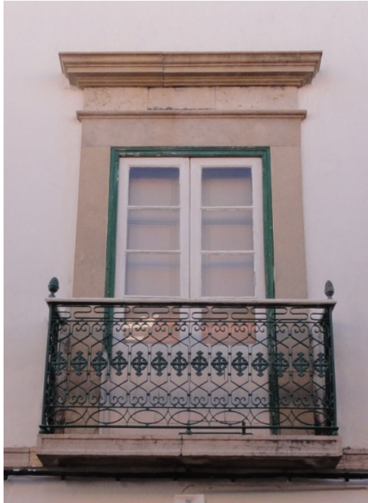
Fig.23-Janela de sacada de desenho tradicional de duplo lintel e cimalha saliente. O gradeamento de ferro forjado apresenta semelhanças com o Solar dos Pantojas e Casa nobre Gama Lobo de Loulé.
