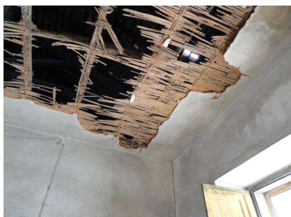
Fig.194 -Cobertura em fasquiado (“câmara”) – casa Azevedo e Silva
