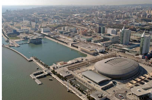
Figura 15 – Vista aérea do Parque das Nações em Lisboa ( http://www.parqueexpo.pt )
