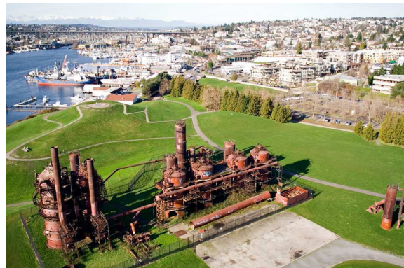
Figura 6 – Casa da caldeira do Gas Works Park ( http://www.cityofseattle.net )
