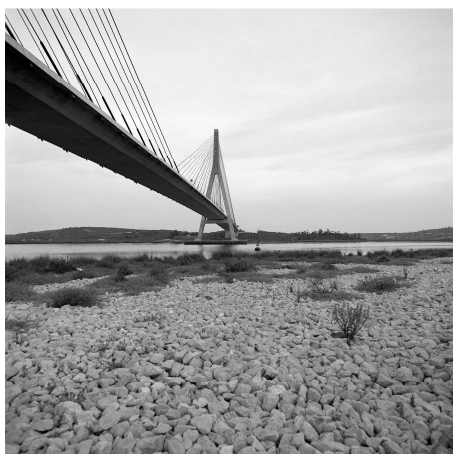
Figura 36 – Ponte sobre o Guadiana. Castro Marim (prox.). 2001
