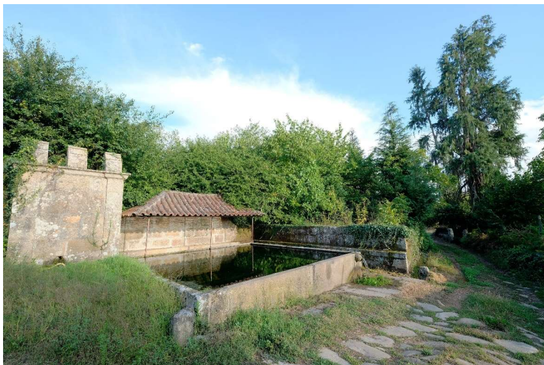
Figura IV. 18– Tanque de distribuição, quinta da casa de Urros Fonte: Ricardo Correia, 2023
