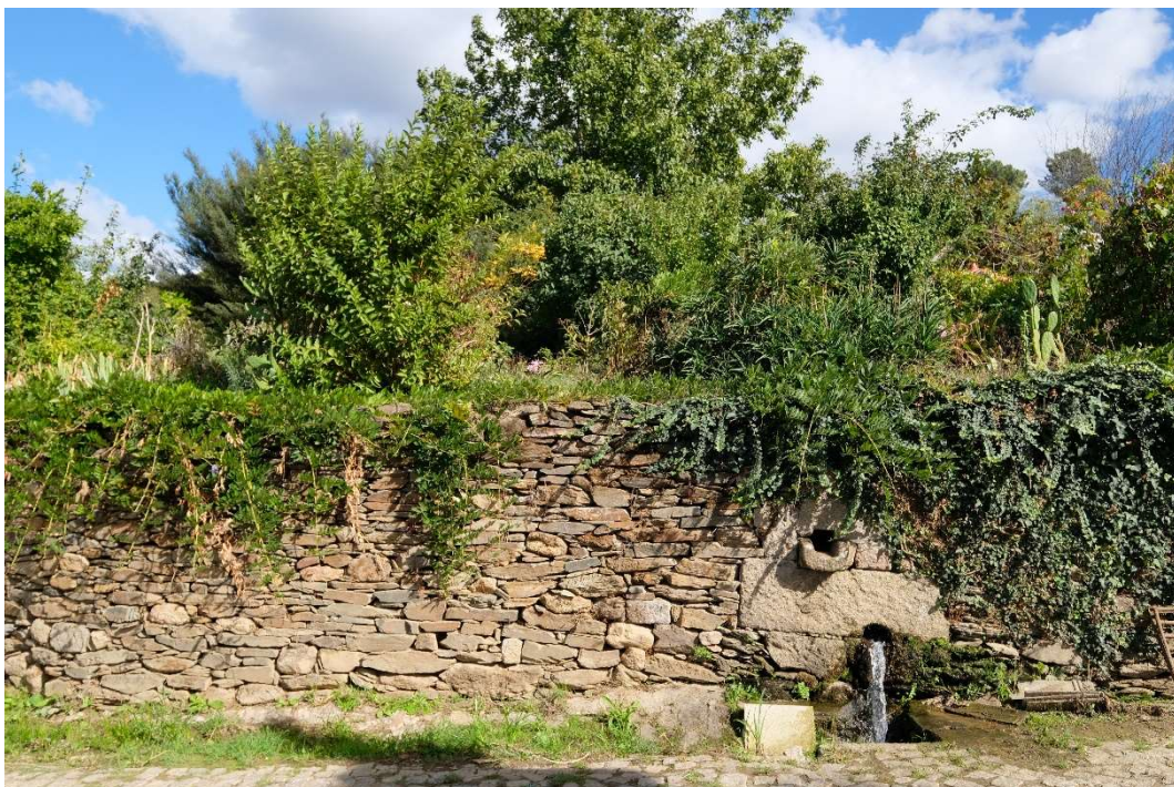
Figura IV. 38– Levadas de Arroios Alvenaria seca de pedra mista Fonte: Ricardo Correia, 2023
