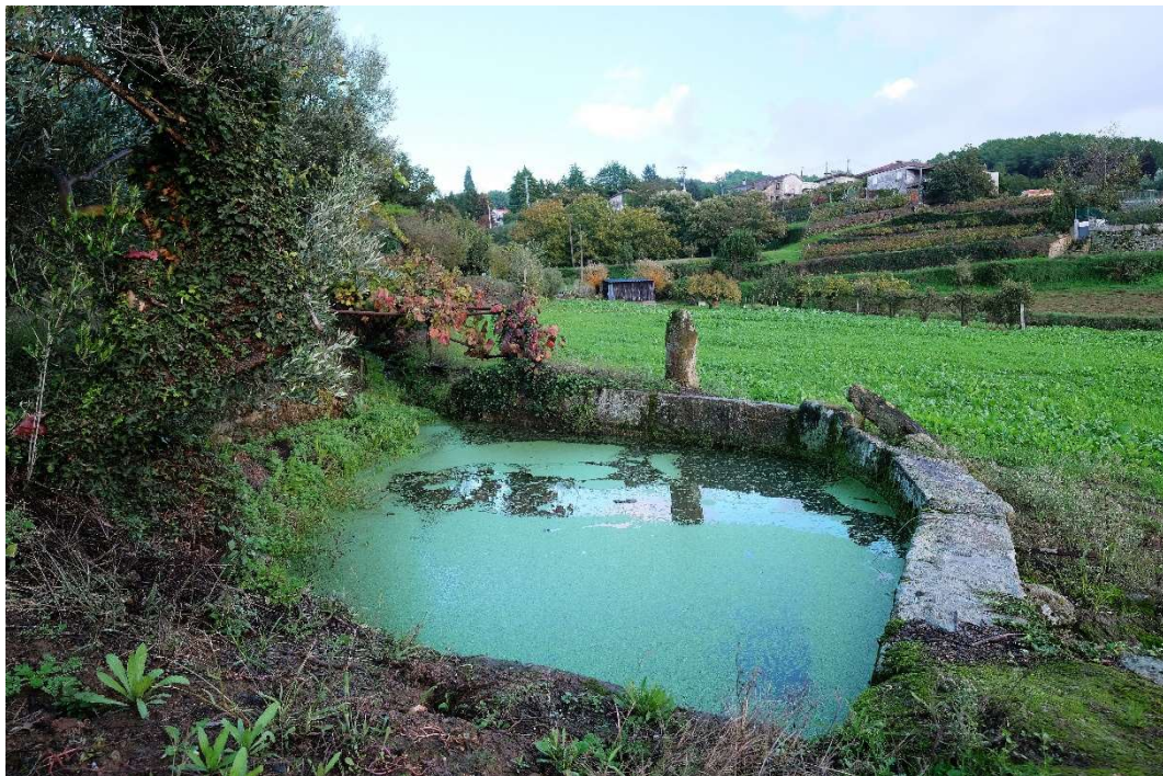
Figura IV. 29– Tanque de distribuição, quinta do Paço Fonte: Ricardo Correia, 2023
