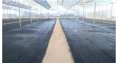
Figura 2.14 - Pavimento do viveiro coberto com PP e arruamentos em betão.
