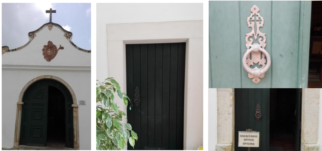
Figuras 19, 20, 21 e 22: Fechaduras de portas do claustro, Sé de Faro
