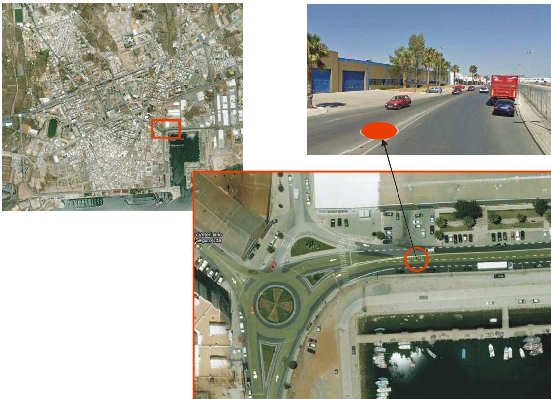
Figura 3.29 – Localização da situação identificada na Avenida dos Operários Conserveiros (no coletor do Brejo).
