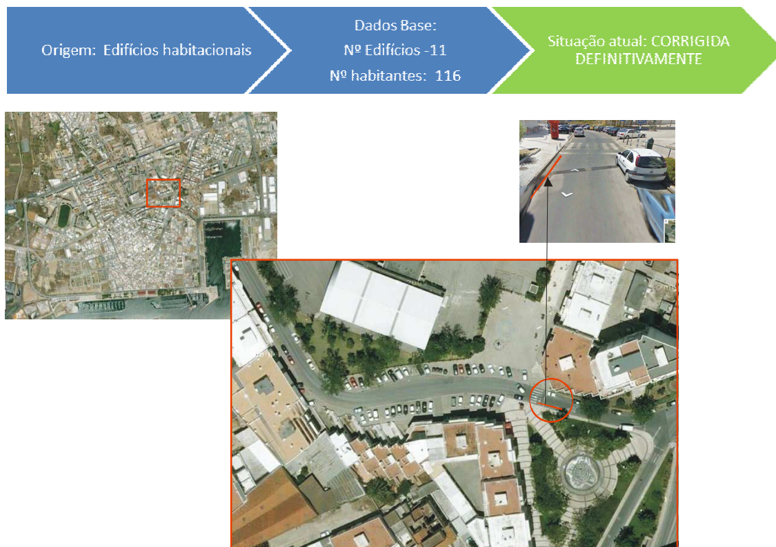
Figura 3.19 – Localização da situação identificada na Av. Dr. Francisco Sá Carneiro.
