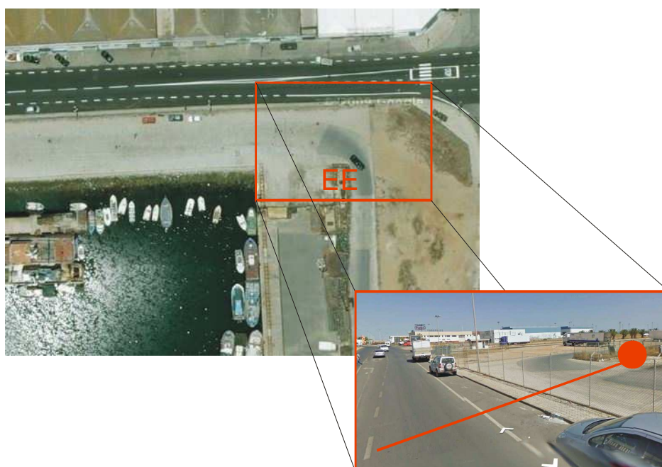
Figura 3.37 – Ponto de ligação da rede interna do Porto de Pesca à rede pública de drenagem de águas residuais – situação após correção.
