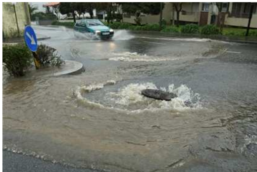
Figura 2.5 – Ilustração da falta de capacidade do sistema de drenagem em situação de pluviosidade intensa.
