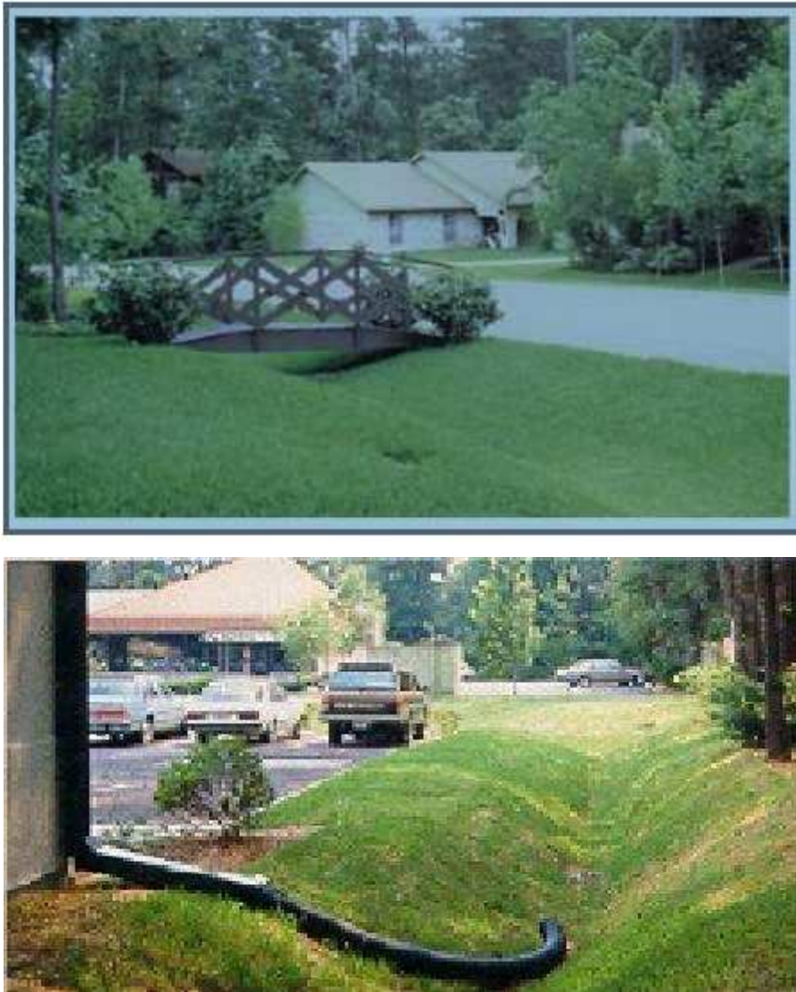
Figura 2.9 - Vala relvada integrada em espaço verde (Vale, 2011).
