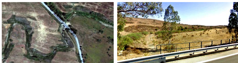
- PH10 – Km 64+019 – Ponte do Azeite;
