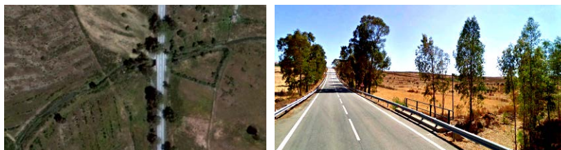
- PH8 – Km 58+810 – Ponte do Álamo;
