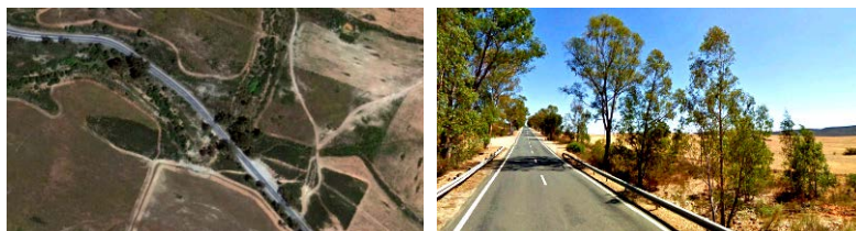
- PH7 – Km 41+396 – Passagem Hidráulica de Mata Filhos;
