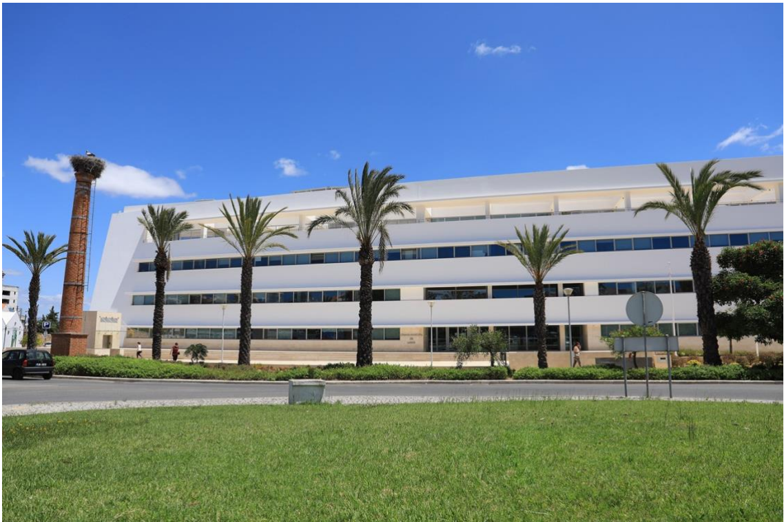
Figura 4.1- Câmara Municipal de Lagos, Edifício Paços do Concelho Séc. XXI
